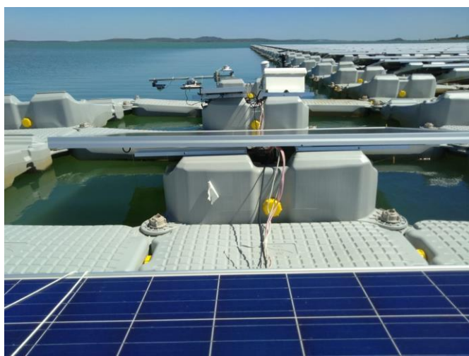
b) Vista posterior e detalhe dos flutuadores principal e secundário
