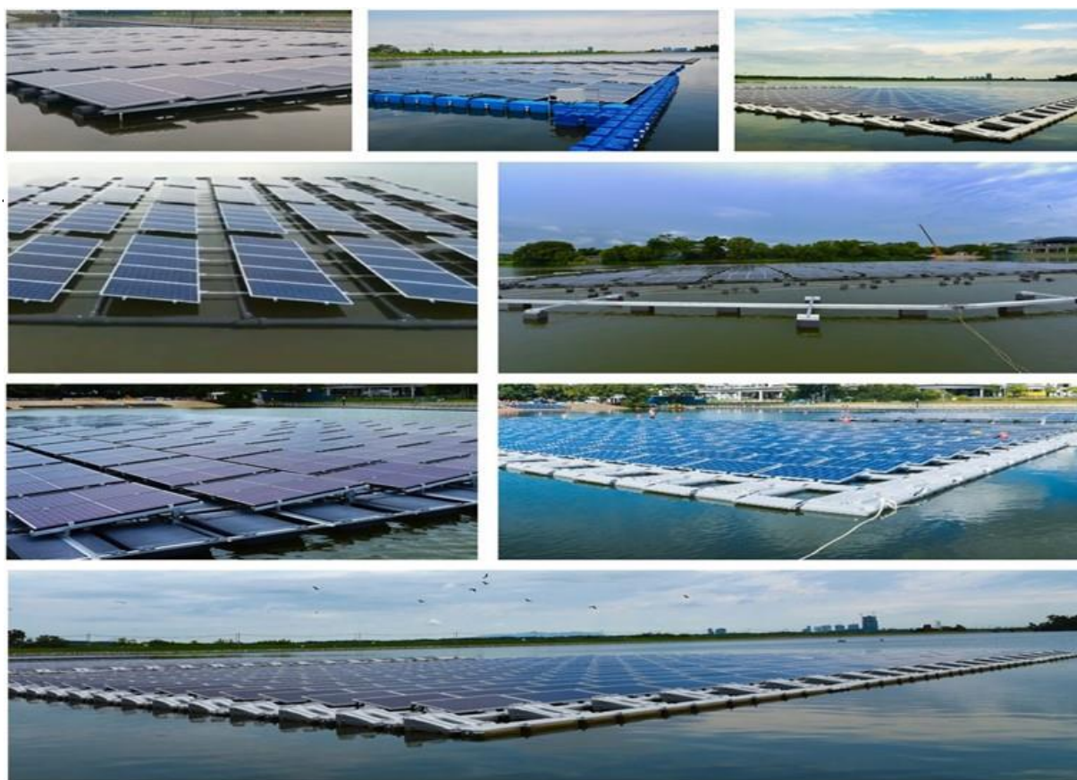
Figura 9 - Tipos de flutuadores e arranjos instalados na área de teste do (SERIS)
