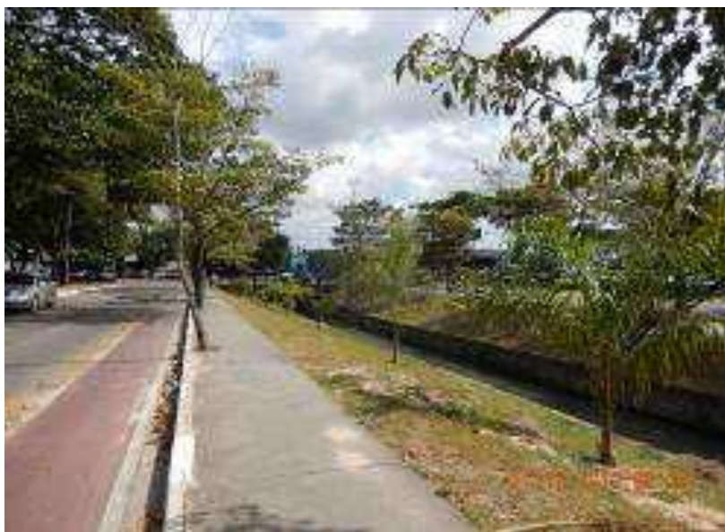
Figura 13: Trecho do riacho Cavouco mostrando margens canalizadas, área gramada na calha expandida, passeio para pedestre e ciclovia.
