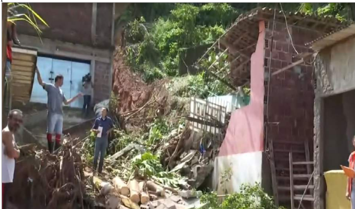
Figura 102 - Escorregamento ES3123 no bairro de Dois Carneiros em Jaboatão do Guararapes. Uma pessoa veio a óbito.
