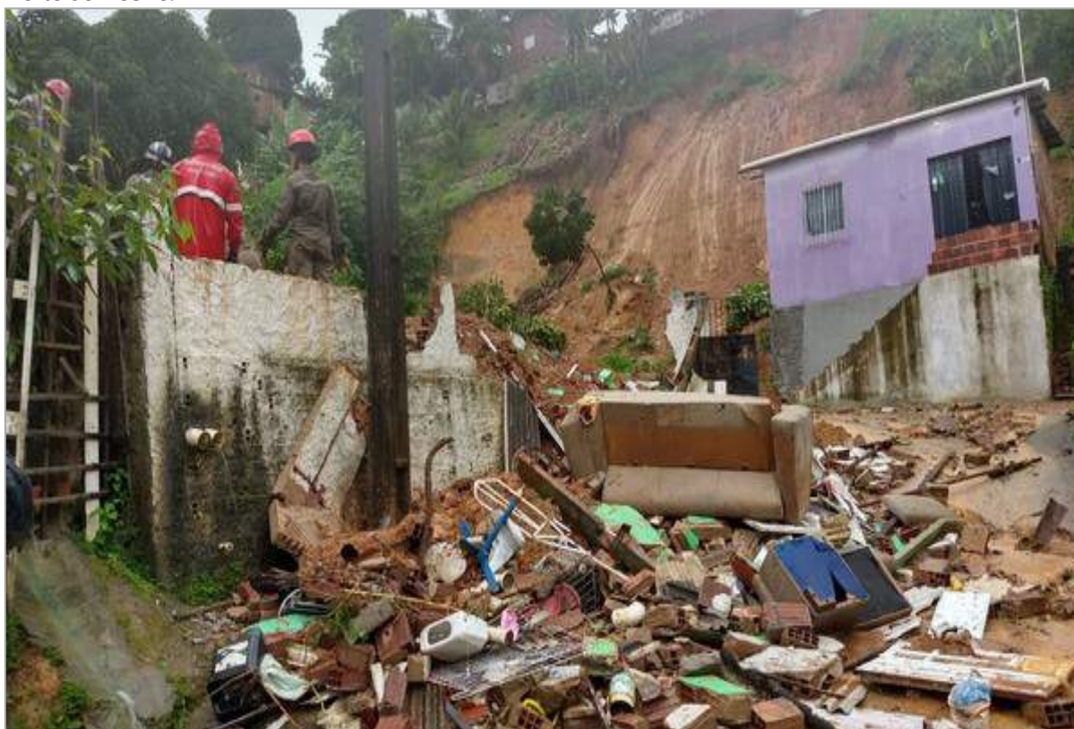
Figura 104 - Escorregamento ES3125 que causou o óbito de dois idosos no bairro de Passarinho, Zona Norte de Recife.
