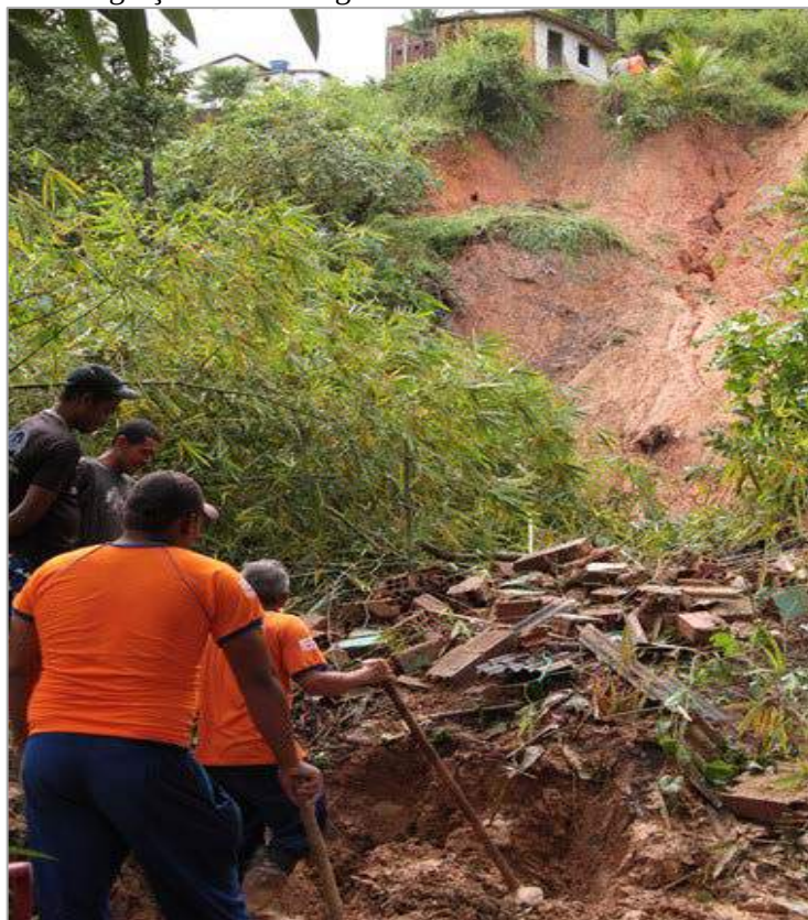
Figura 100 - Escorregamento ES0223 no bairro de Tabatinga no município de Camaragibe. Destaca-se a forma de ocupação (construção de moradia, cortes na encosta e vegetação inapropriada) como principal variável para deflagração de escorregamento.
