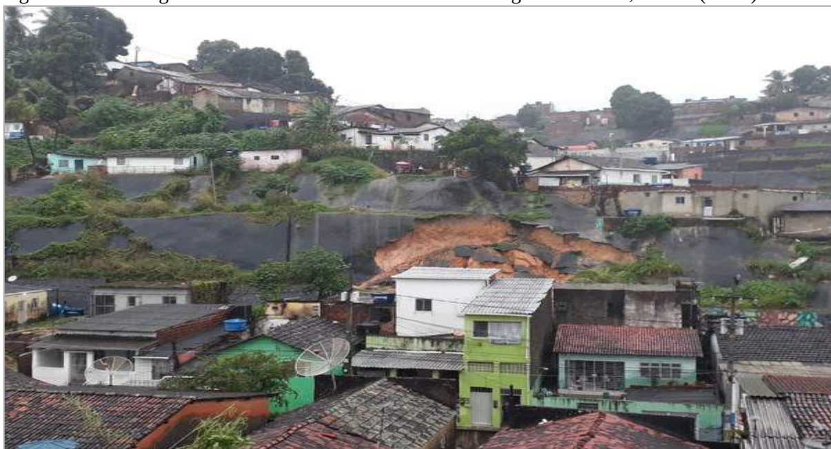
Figura 96 - Escorregamento ES2012 em área de risco no Córrego do Abacaxi, Olinda (RMR).
