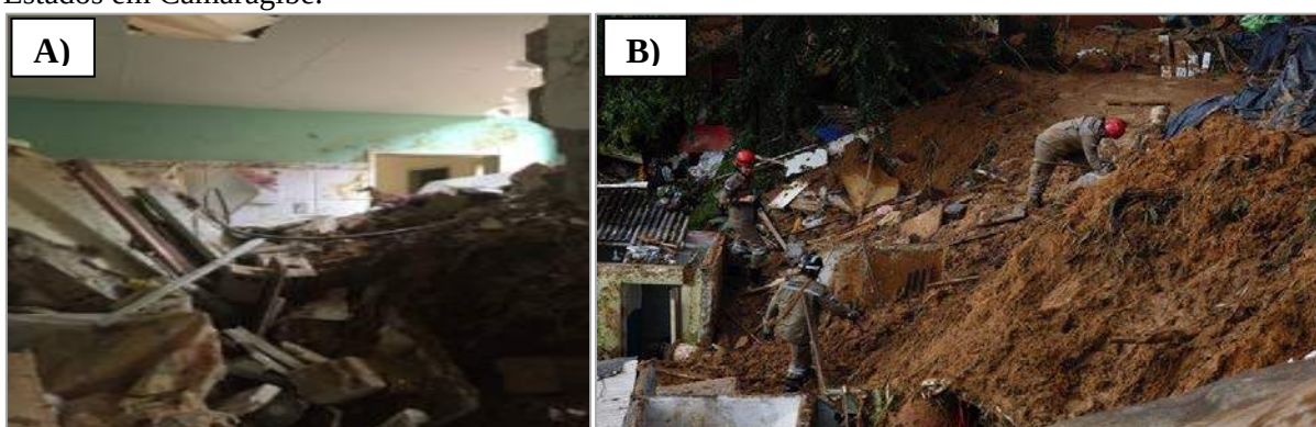
Figura 114 - Danos causados por escorregamentos. A) Escorregamento que destruiu parte de moradia no bairro Dois Unidos em Recife; B) Escorregamento que causou o óbito de 5 pessoas no Bairro dos Estados em Camaragibe.
