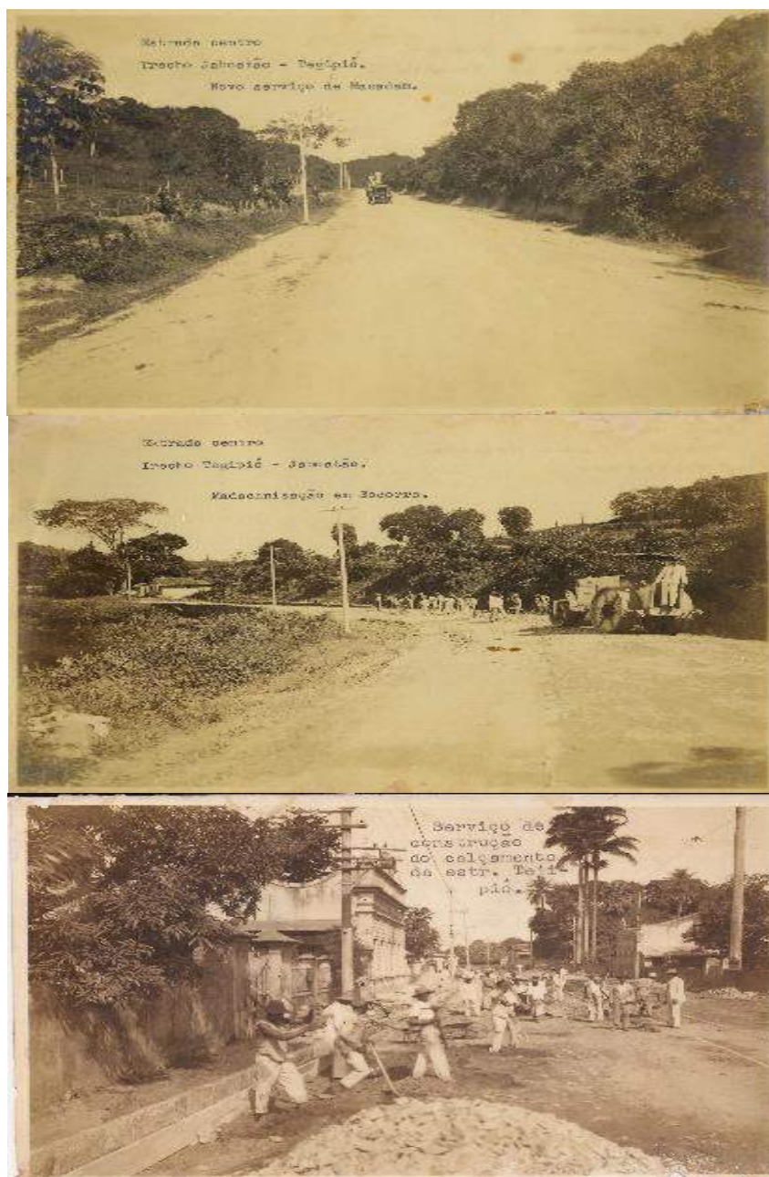
Figura 6. Construção da estrada de Tejipió.
