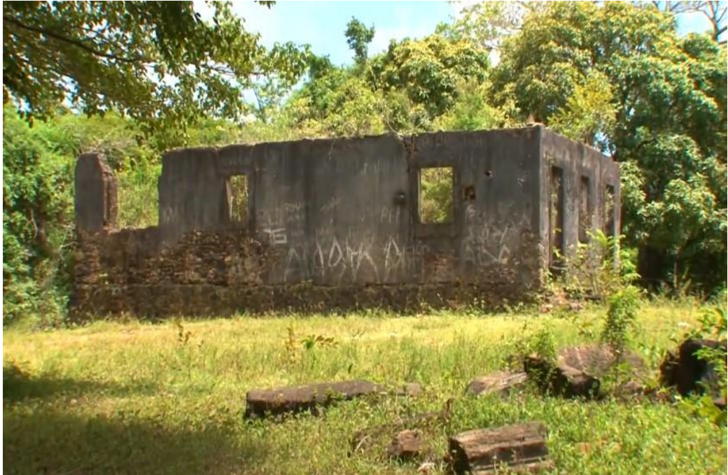
Figura 13 – Ruínas da Igreja Nossa Senhora dos Prazeres – Paulista (PE). Edificação situada ao lado das ruínas da igreja, pertencente a uma possível casa paroquial.
