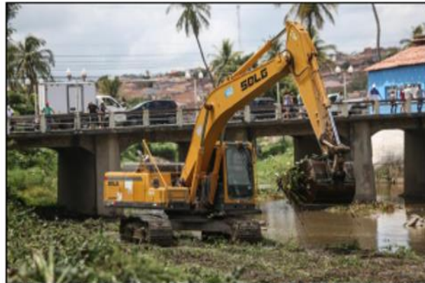
Limpeza do Rio Ipojuca. Foto: Allan Torres / SECOM Gravatá. 2018
