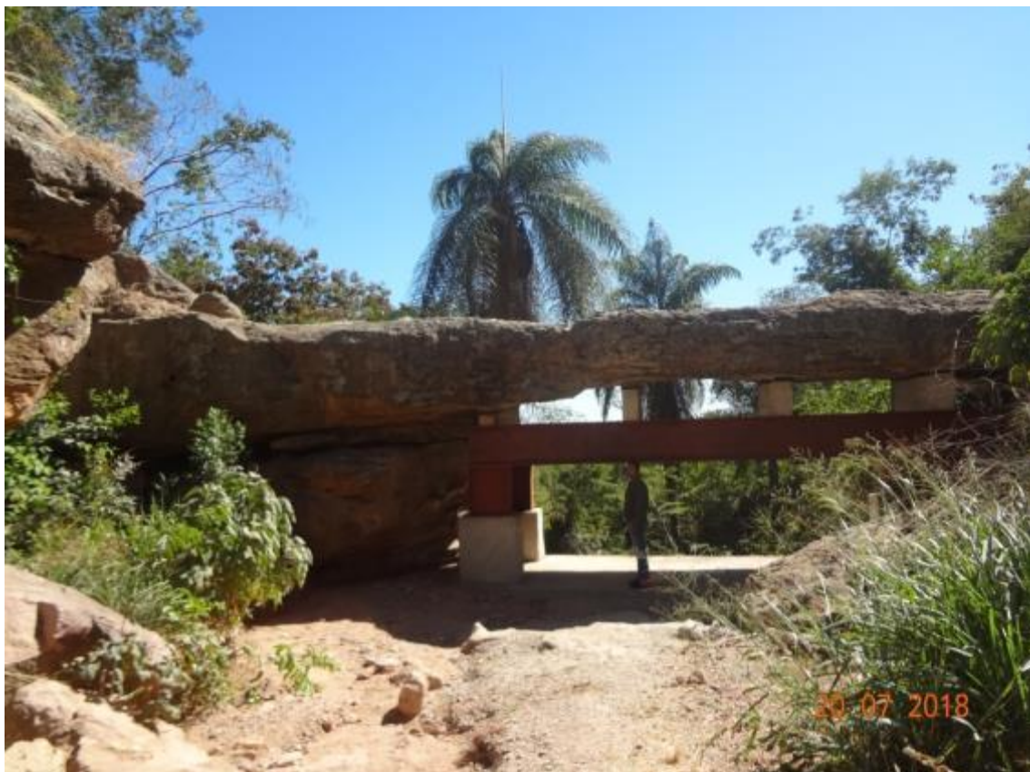
Figura 59 - Geossítio Ponte de Pedra após a colocação da estrutura de sustentação
