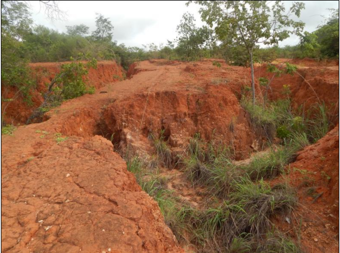
Figura 28 – Voçorocamento em área de Luvisolo Crômico (Coordenada Geográfica: Lat. 6°51'56.65"S / Long. 39°30'52.55"O).
