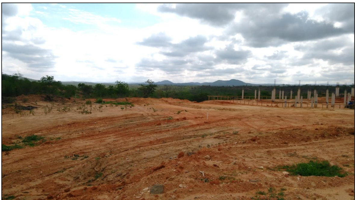
Figura 34 – Terreno passando por processos de terraplanagem (Coordenada Geográfica: Lat. 6°56'34.37"S / Long. 39°33'35.62"O).
