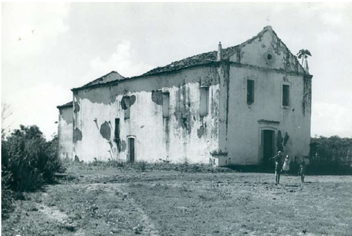
Imagem 43: Vista da igreja potiguar de São Miguel Arcanjo com a coberta desabada. Arquivo da Superintendência do Iphan na Paraíba. Foto: autor desconhecido, provavelmente em 1978.
