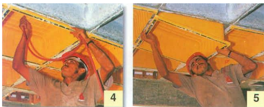
Figura 2.10 – Retirada dos caixotes. (FORMPLAST, 1998 apud ALBUQUERQUE, 1999).
