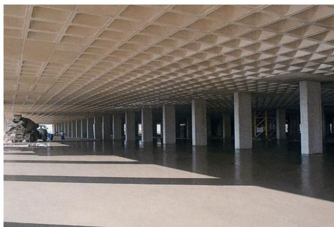
Figura 2.13 – Laje nervurada construída com caixotes ( www.atex.com.br ).
