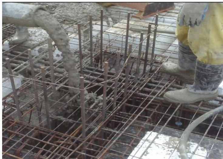
Figura 2.19 – Concretagem do maciço (NOGUEIRA & CASTRO, 2010)
