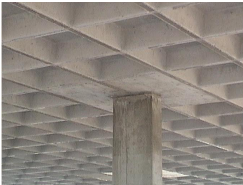
Figura 2.17 – Laje lisa nervurada apoiada sobre pilares (SPOHR, 2008)
