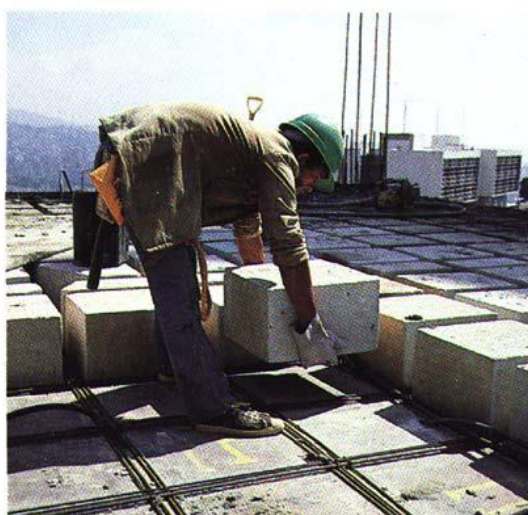
Figura 2.8 – Montagem dos blocos para as lajes nervuradas moldadas “in loco” (BOCCHI & GIONGO, 2010).
