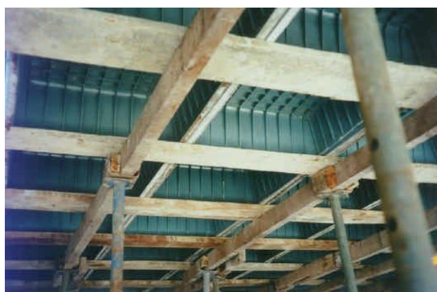
Figura 2.11 – Escoramento dos caixotes sem assoalho (ALBUQUERQUE, 1999).
