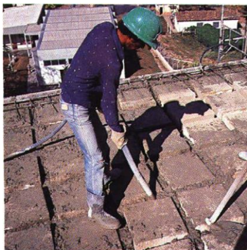
Figura 2.9 – Lançamento e adensamento do concreto em lajes nervuradas moldadas no local (BOCCHI JR & GIONGO, 2010).
