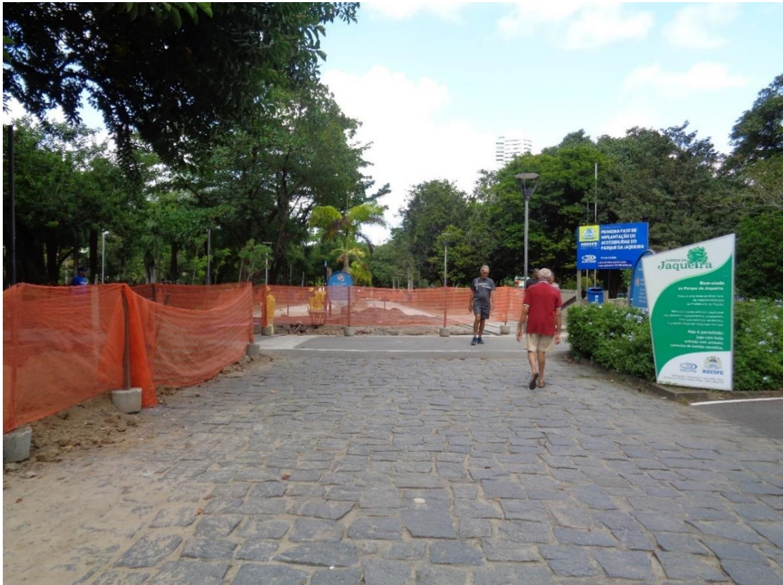
Figura 47 - Parque da Jaqueira – Zona Norte, manutenção constante. Reforma dos acessos para adequação a mobilidade.
