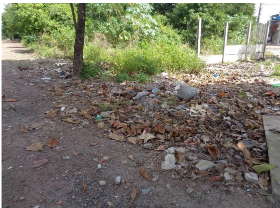
Figura 28 - Parque do Jiquiá – Zona Oeste, falta de manutenção e falta de investimentos, entorno, sem manutenção, falta de limpeza e acúmulo de folhas e lixo.
