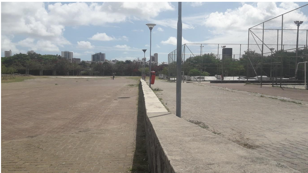
Figura 72 - Parque do Caiara – Pista de corrida e quadras sem manutenção e solo sem preservação, grades resgadas e enferrujadas, local sem frequentadores.
