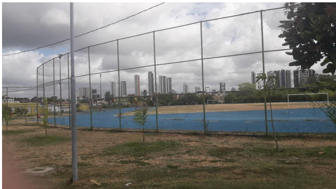
Figura 66 - Parque do Caiara – Pista de corrida sem manutenção e solo sem preservação, local sem frequentadores.
