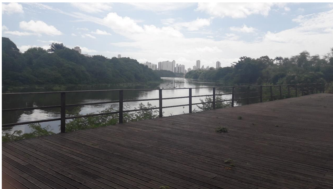
Figura 82 - Parque do Caiara – Área sem manutenção e solo sem preservação, local sem frequentadores.
