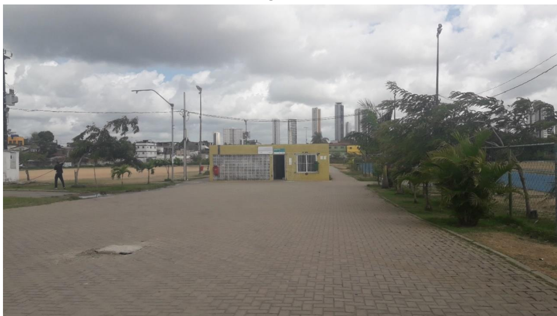
Figura 64 - Parque do Caiara – Sem manutenção e solo sem preservação, local sem frequentadores
