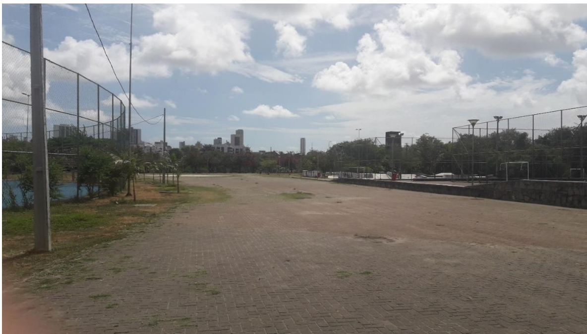
Figura 68 - Parque do Caiara – Pista de corrida e quadras sem manutenção e solo sem preservação, local sem frequentadores.
