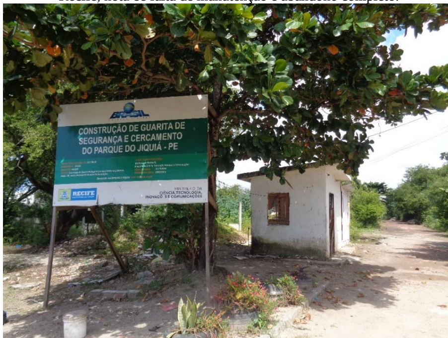
Figura 88 - Parque do Jiquiá – Entrada: Área de baixo valor imobiliário na zona oeste da cidade do Recife, nota-se falta de manutenção e abandono completo.
