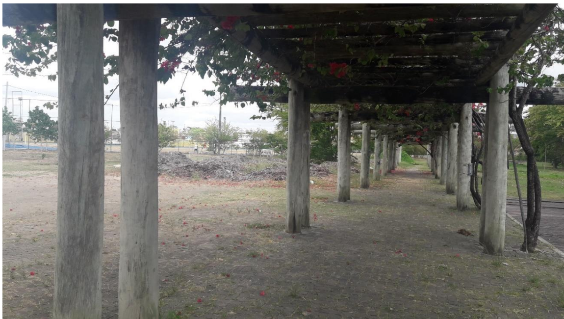
Figura 80 - Parque do Caiara – Área sem manutenção e solo sem preservação, local sem frequentadores.
