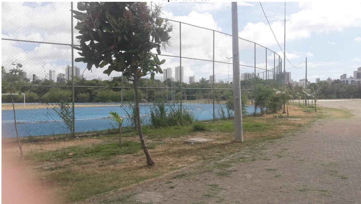
Figura 67 - Parque do Caiara – Pista de corrida sem manutenção e solo sem preservação, local sem frequentadores.
