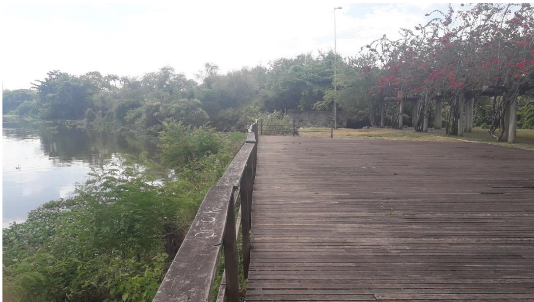
Figura 84 - Parque do Caiara – Área sem manutenção e solo sem preservação, local sem frequentadores.
