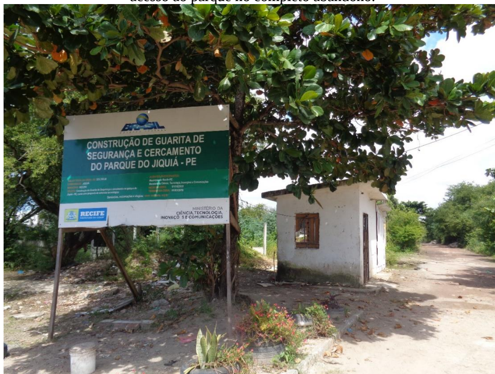
Figura 23 - Parque do Jiquiá – Zona Oeste, falta de manutenção e falta de investimentos, guarita de acesso ao parque no completo abandono.
