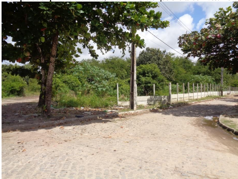
Figura 26 - Parque do Jiquiá – Zona Oeste, falta de manutenção e falta de investimentos, entorno.
