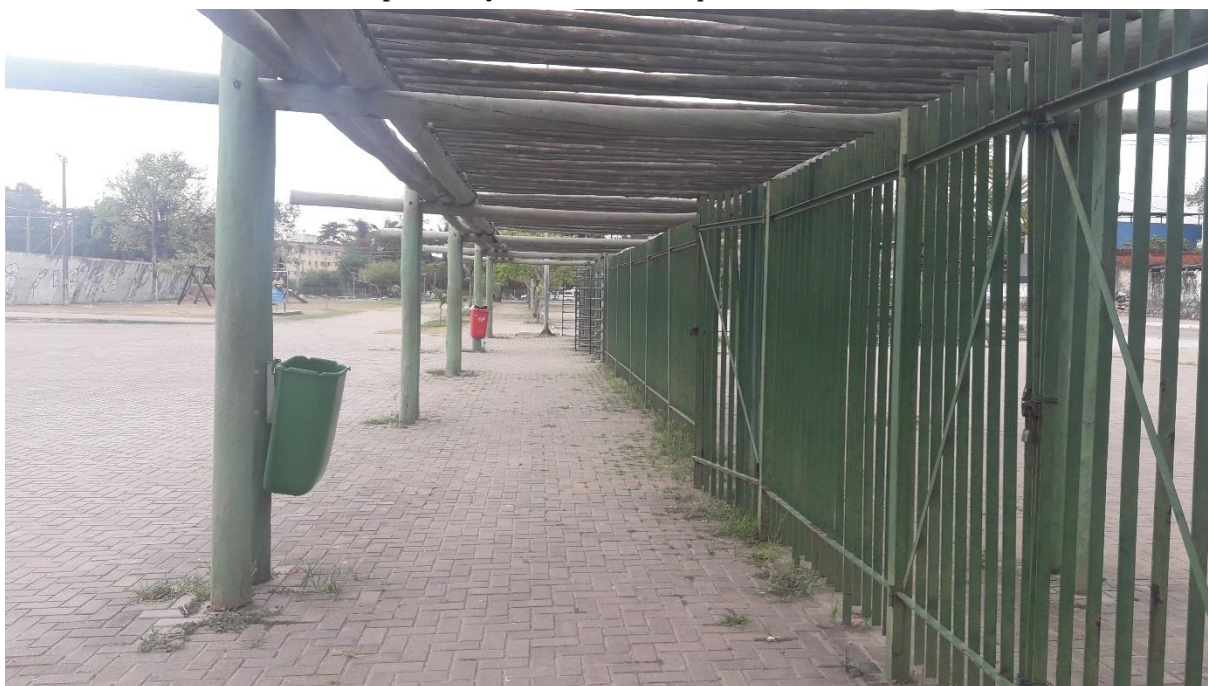
Figura 61 - Parque do Caiara – Entrada principal trancada, falta de manutenção constante, solo sem preservação, local sem frequentadores.
