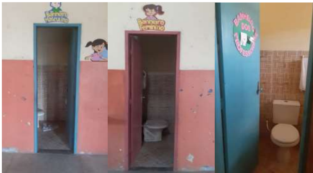
Fotografia 34 - Banheiros da Escola Municipal Prefeito Gabriel Mesquita de Freitas
