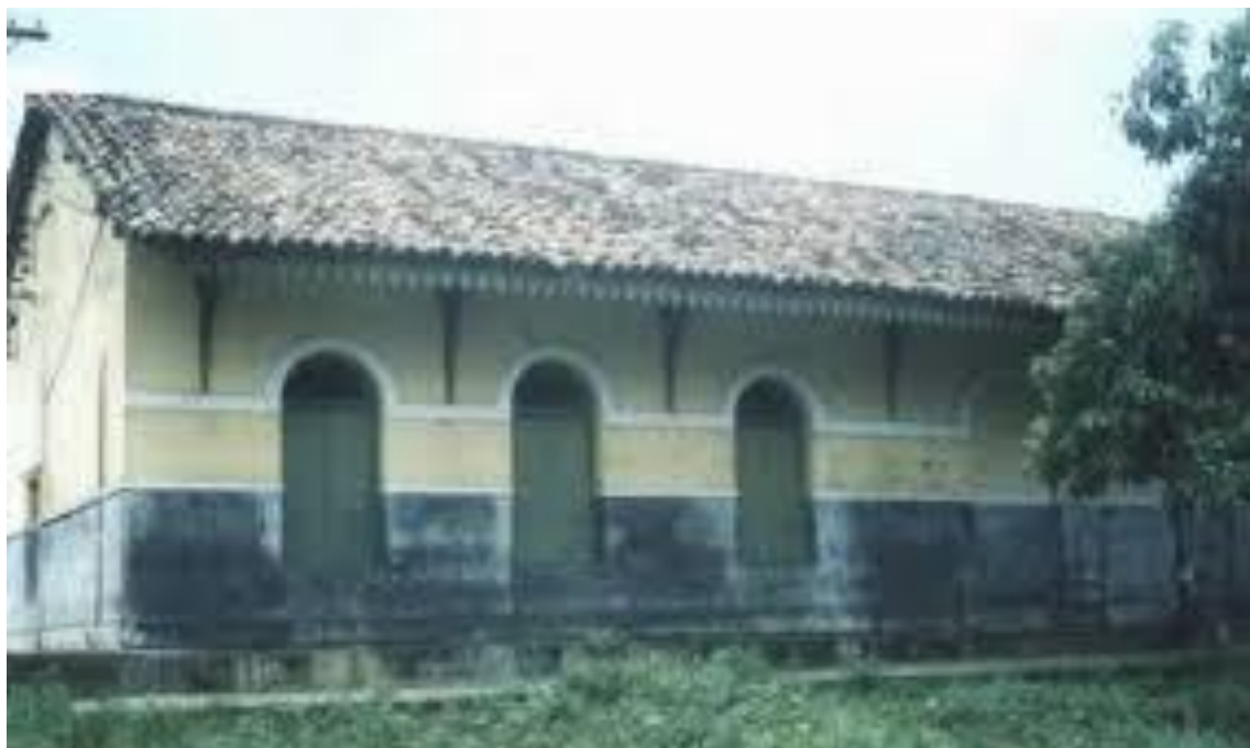
Anexo 08. Fachada lateral da estação ferroviária de Nazaré, vendo-se os lambrequins em madeira, mãos francesas em ferro, portas e janelas em madeira. Dec.1990.
