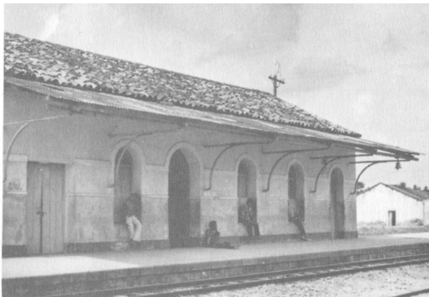
Estação Ferroviária de Nazaré da Mata: fachada voltada para a linha férrea, notando-se a substituição do telhamento da cobertura da plataforma por amianto.
