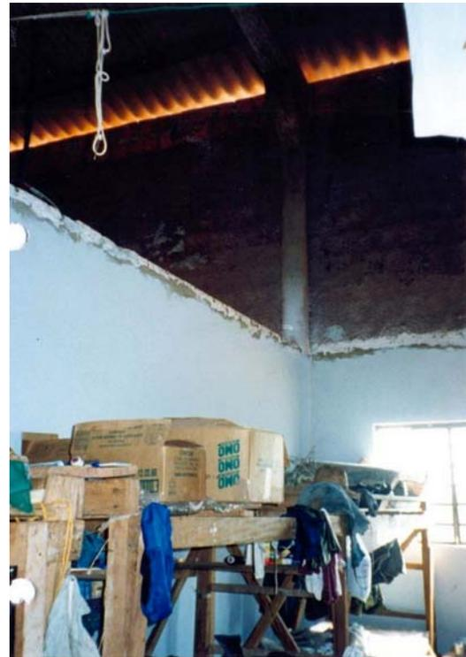
Figura 66: Reforma dos quartos com elevação do pé direito, para propiciar ventilação e iluminação.
