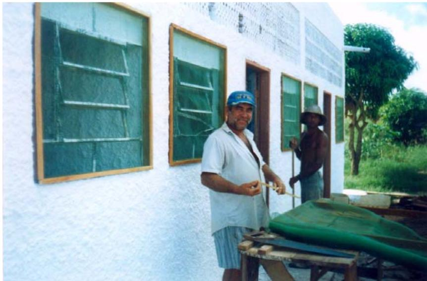
Figura 58: Reforma de alojamentos com colocação de telas protetoras contra mosquitos.
