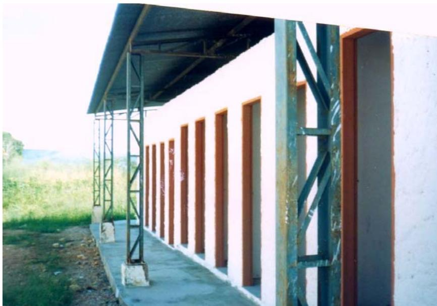
Figura 59: Reconstrução de calçadas e telhados, inclusive extensão do telhado nas portas de banheiros para evitar alagamento.
