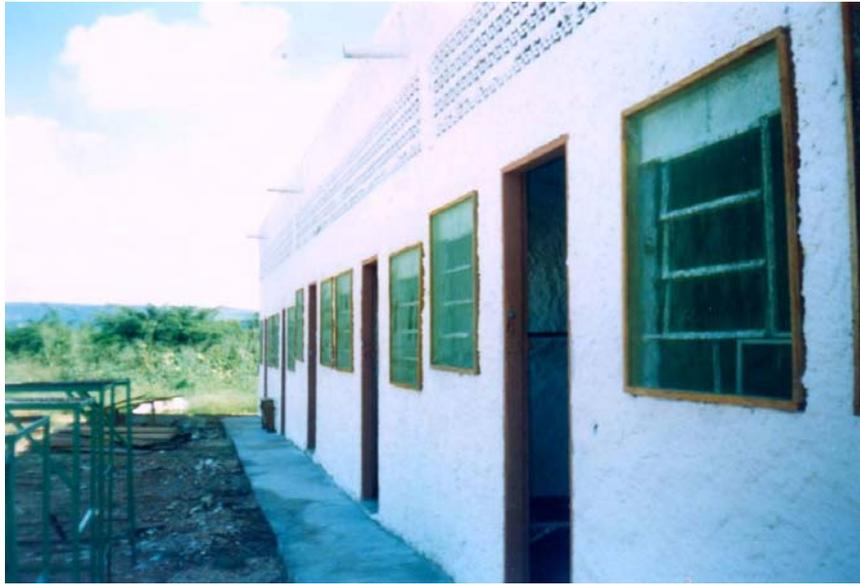
Figura 65: Recuperação de calçadas, pintura de paredes, portas e camas, colocação de telas anti-mosquitos.
