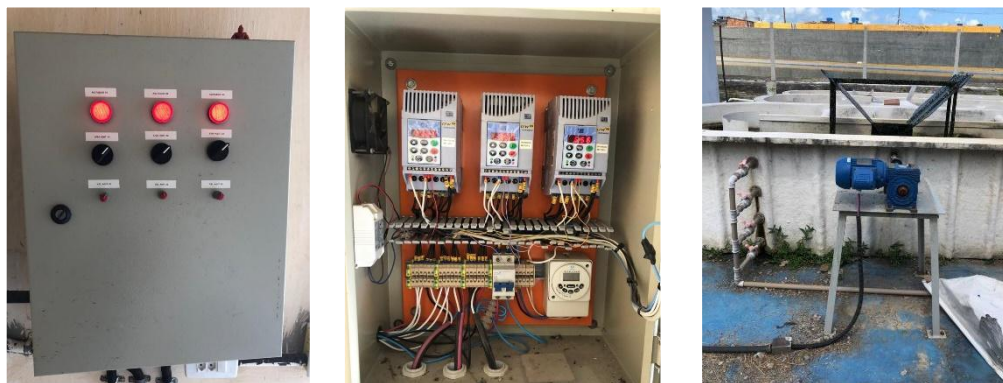
Figura 10 - a), b) e c) Características do motor-redutor para mistura nas LATs
