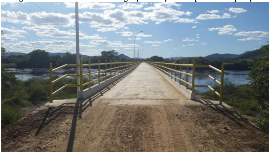
Figura 18: Ponte sobre o Rio Paraguaçu em Iaçu/BA depois da recuperação
