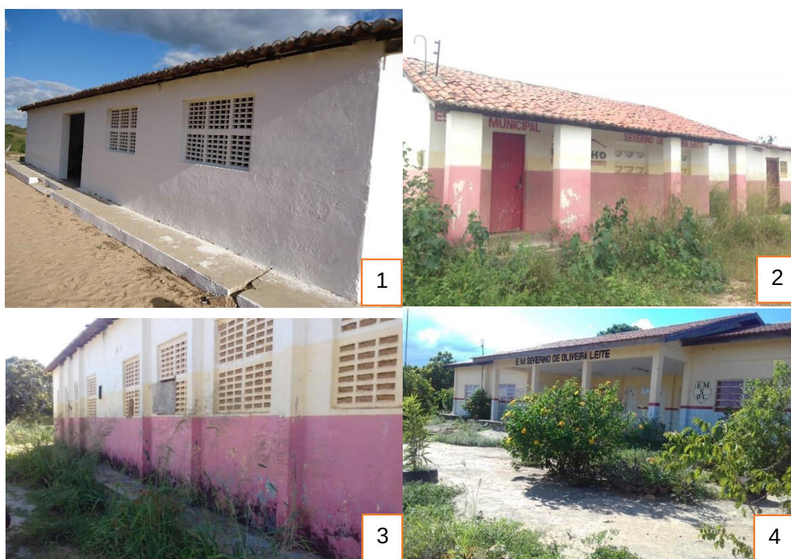
1 - Escola fechada do Caldeirão, atualmente ocupada como sede da associação; 2 – Escola fechada do Mussambê; 3 – Escola fechada do Boqueirão; 4 – Nova escola nucleada do Mussambê. Fotos: Irailda Rodrigues, em março/2021.
