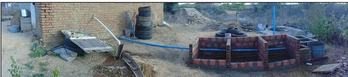
**Figura 3:** visão do sistema de compostagem e do filtro de águas cinza acoplado, bem como da antiga saída de águas cinza.
