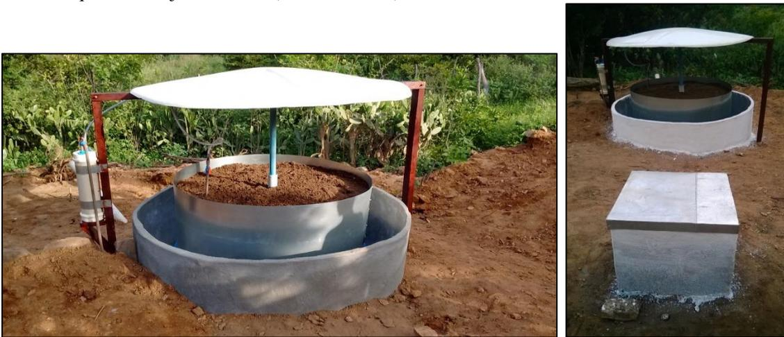
**Figuras 7 e 8:** biodigestor finalizado e visão da caixa de abastecimento de resíduos dos animais.
