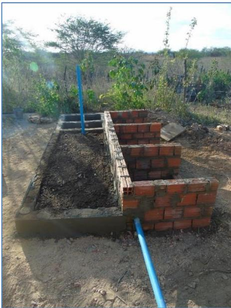
**Figura 2:** Tecnologia: bacia de biorremediação de esgoto doméstico, filtro de águas cinzas e sistema de compostagem.
