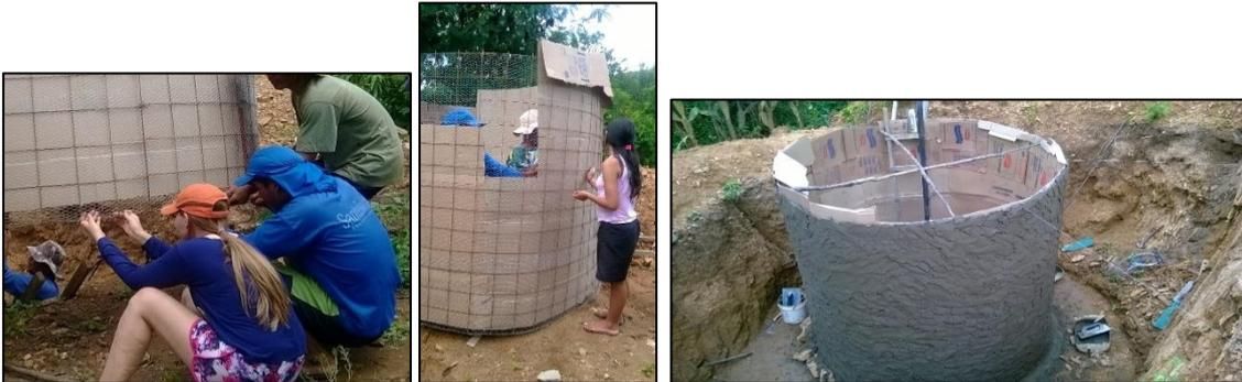
**Figuras 4, 5 e 6:** fases iniciais de montagem do biodigestor. Câmara digestora construída com a tecnologia de ferro e cimento.
