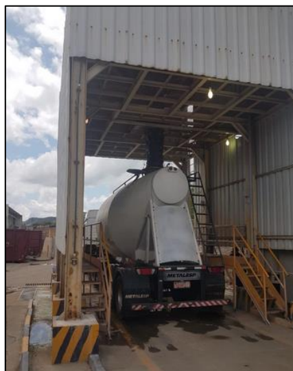
Figura 14 – Silo de Armazenagem na Unidade 08
