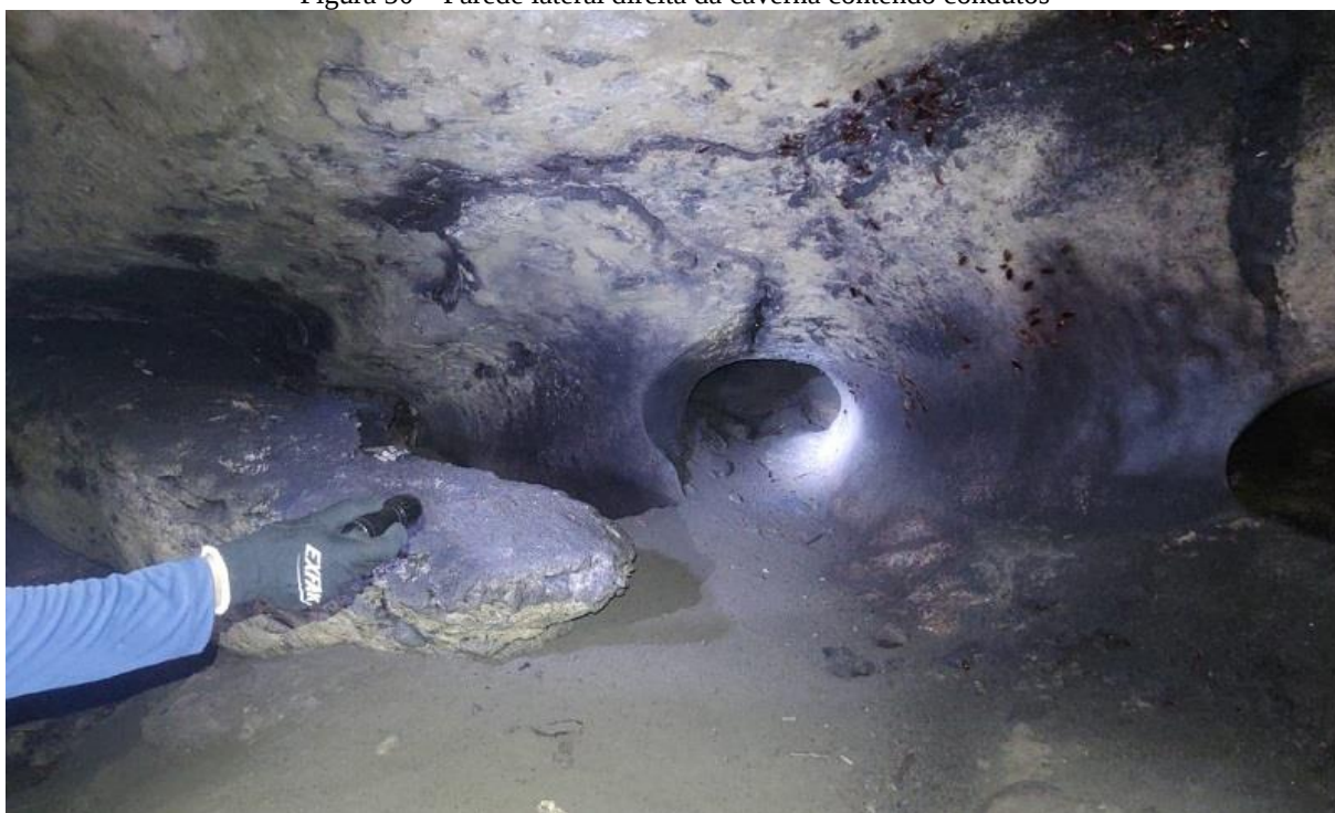
Figura 50 – Parede lateral direita da caverna contendo condutos
