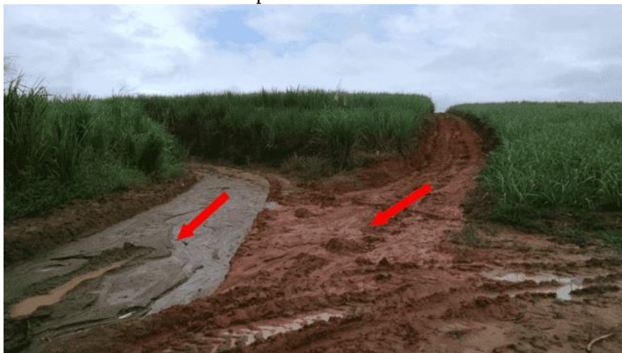
Figura 50 - A erosão desenvolvida nas estradas produz muitos sedimentos, os quais são transportados para os canais.
