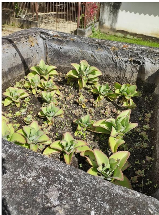
Figura 17 - Telhado verde com vegetação Kalanchoe laetiviren , na célula-teste 5.
