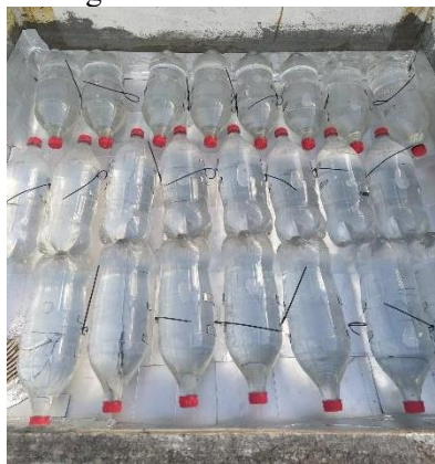
Figura 15 - Etapas de preparação das garrafas PET, para uso no telhado ecológico.
