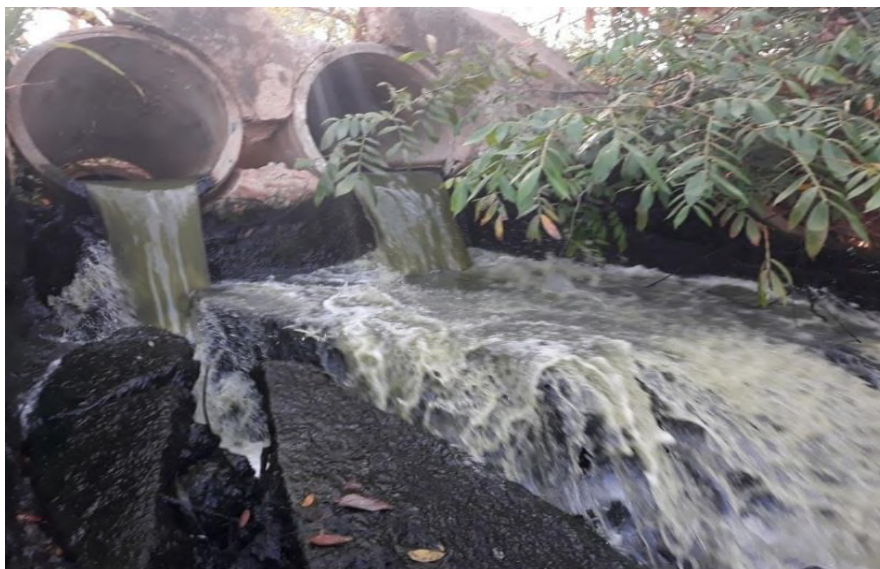
Figura 35 – Saídas de águas servidas in natura , bueiro ETE
