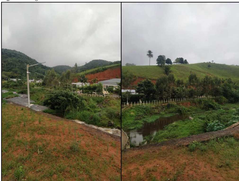
Figura 7- Margens do Rio Panelas em Belém de Maria - PE.
