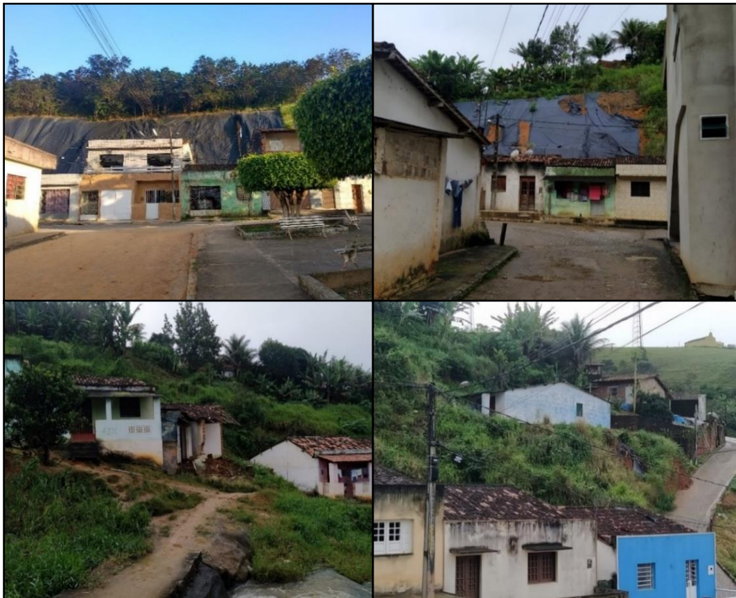
Figura 5- Casas próximas a barreiras.
