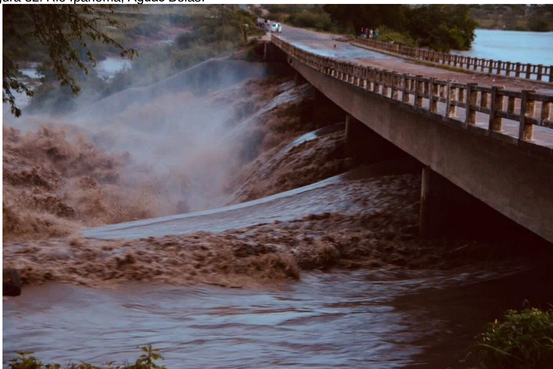
Figura 32: Rio Ipanema, Águas Belas.
