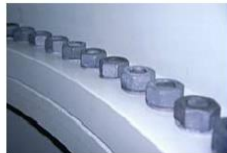
(d) Ligação parafusada dos flanges.
