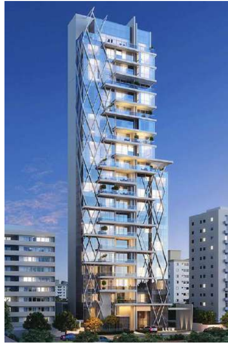
Figura 26 - Edifício Llum Batel (Curitiba-Brasil)
