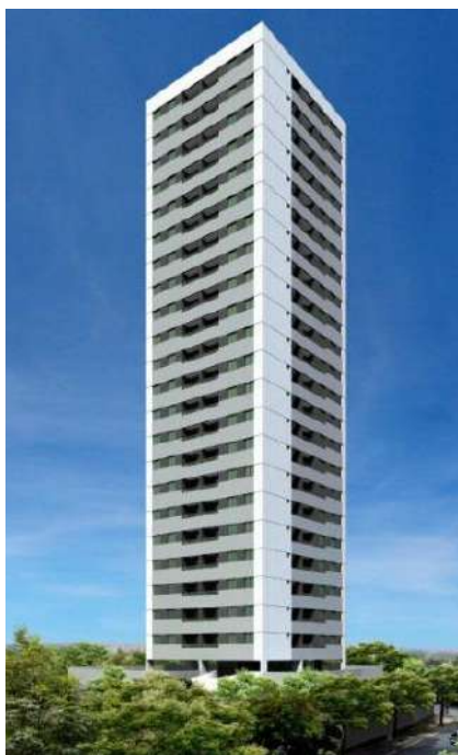
Figura 23 - Edifício Green Life Torre (Recife-Brasil)
