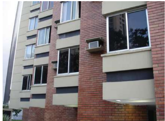
Figura 12 - Tijolos cerâmicos e concreto aparente do Edf. Mirage
