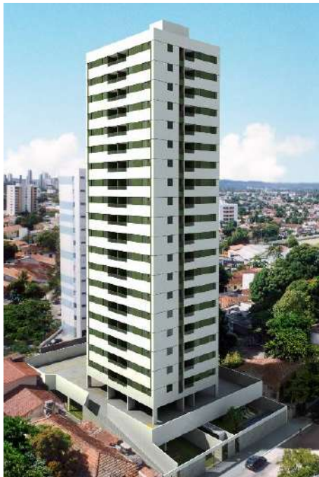
Figura 19 - Edifício Villareal (Recife-Brasil)
