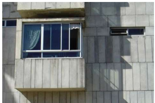
Figura 14 - Revestimento em placas de concreto do Edf. Mirage
