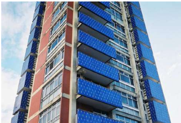
Figura 11 - Azulejos e concreto aparente do Edf. Barão do Rio Branco
