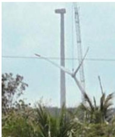
(d) Nacele montada e início da montagem do rotor.
