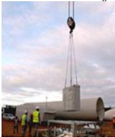
(a) Colocação do Painel de controle na base da fundação.
