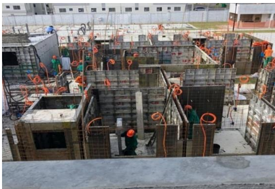
Figura 18. Fôrmas de alumínio – parede de concreto
