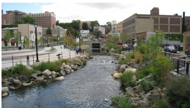
Figura 9 - Saw Mill River, Yonkers, NY, depois da abertura
