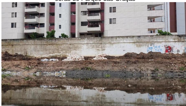
Figura 35 - Edifício de alto padrão no bairro das Graças, as margens do Capibaribe após início das obras do Parque das Graças
