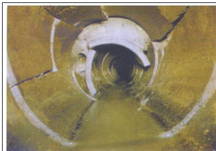
Figura 2.8 - Colapso parcial de uma rede com tubo cerâmico mostrado por vídeo inspeção (Fonte: www.abratt.org.br )
