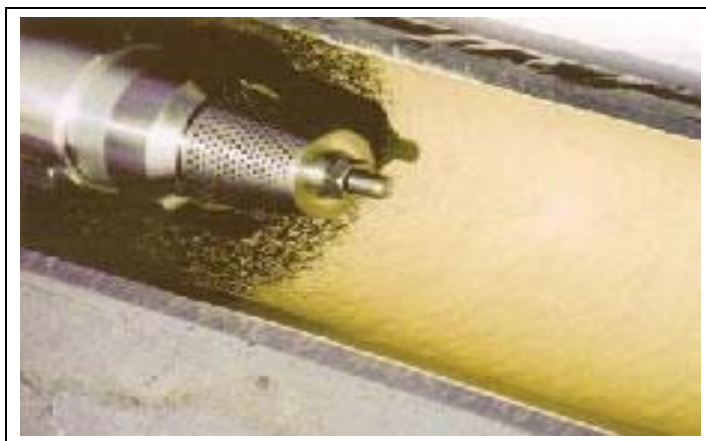
Figura 2.14 - Cabeçote de aspersão de revestimento em epóxi
