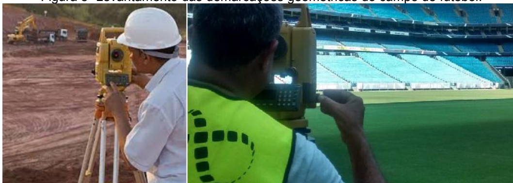
Figura 8- Levantamento das demarcações geométricas do campo de futebol.
