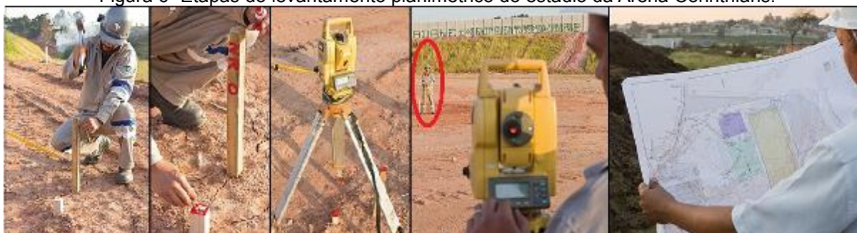
Figura 6- Etapas do levantamento planimétrico do estádio da Arena Corinthians.
