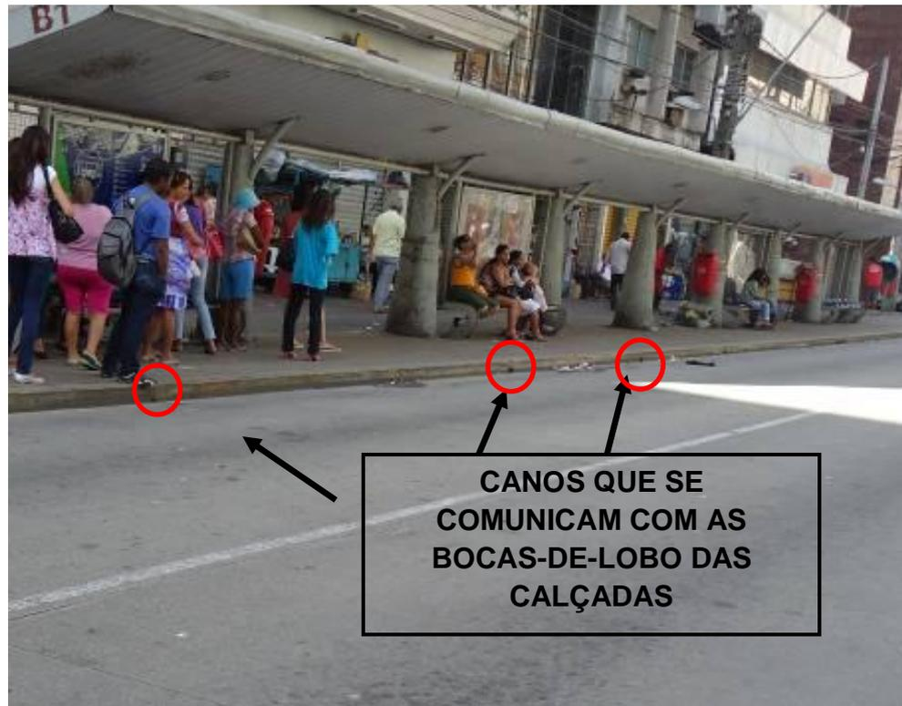
**Figura 26 - Ausência de sarjeta e bocas-de-lobo**
