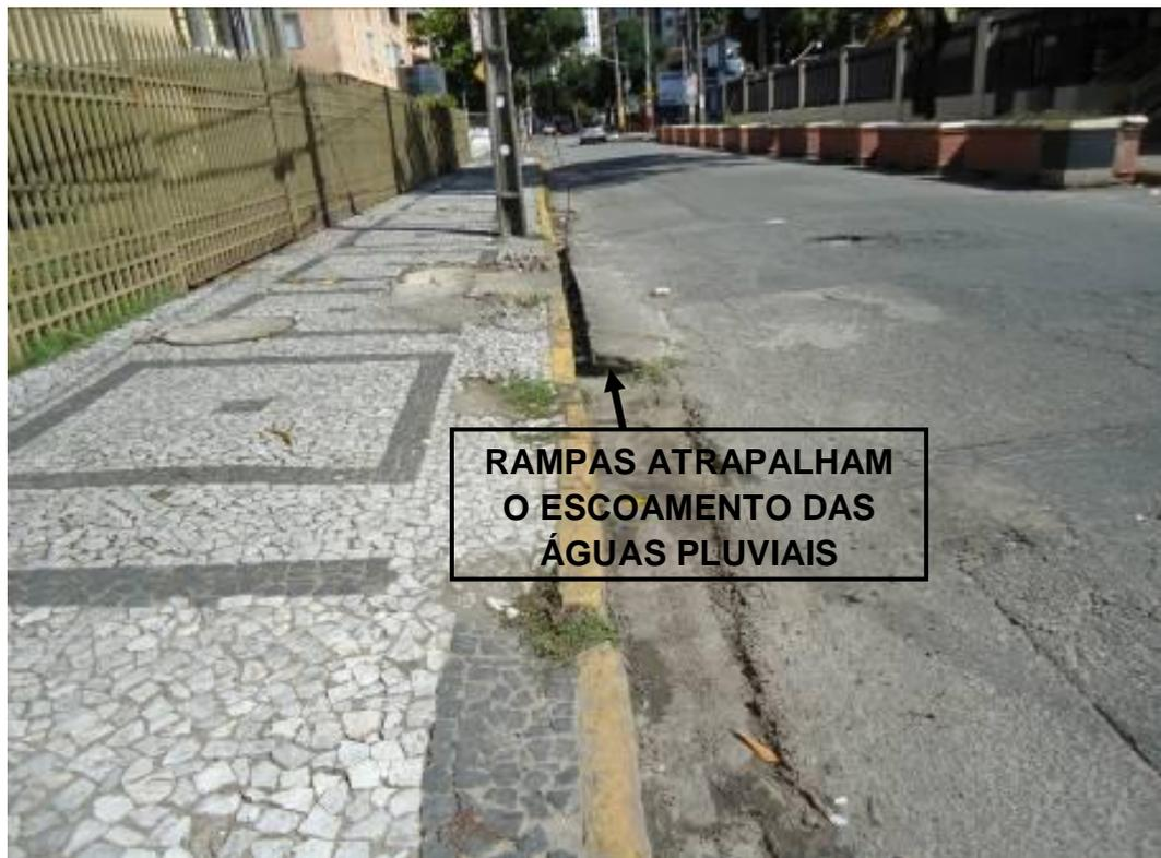
**Figura 36 - Obstrução da sarjeta por rampas de estacionamentos**
