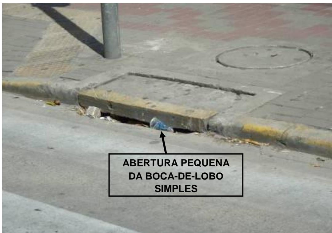
**Figura 30 - Abertura pequena da boca-de-lobo sendo obstruída por lixo**
