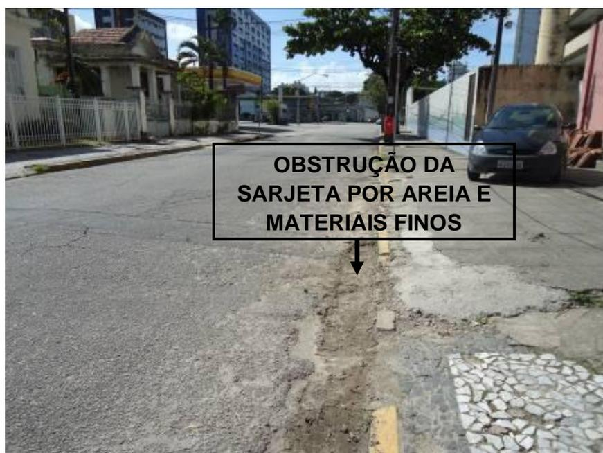
**Figura 35 - Acúmulo de sedimentos nas sarjetas**
