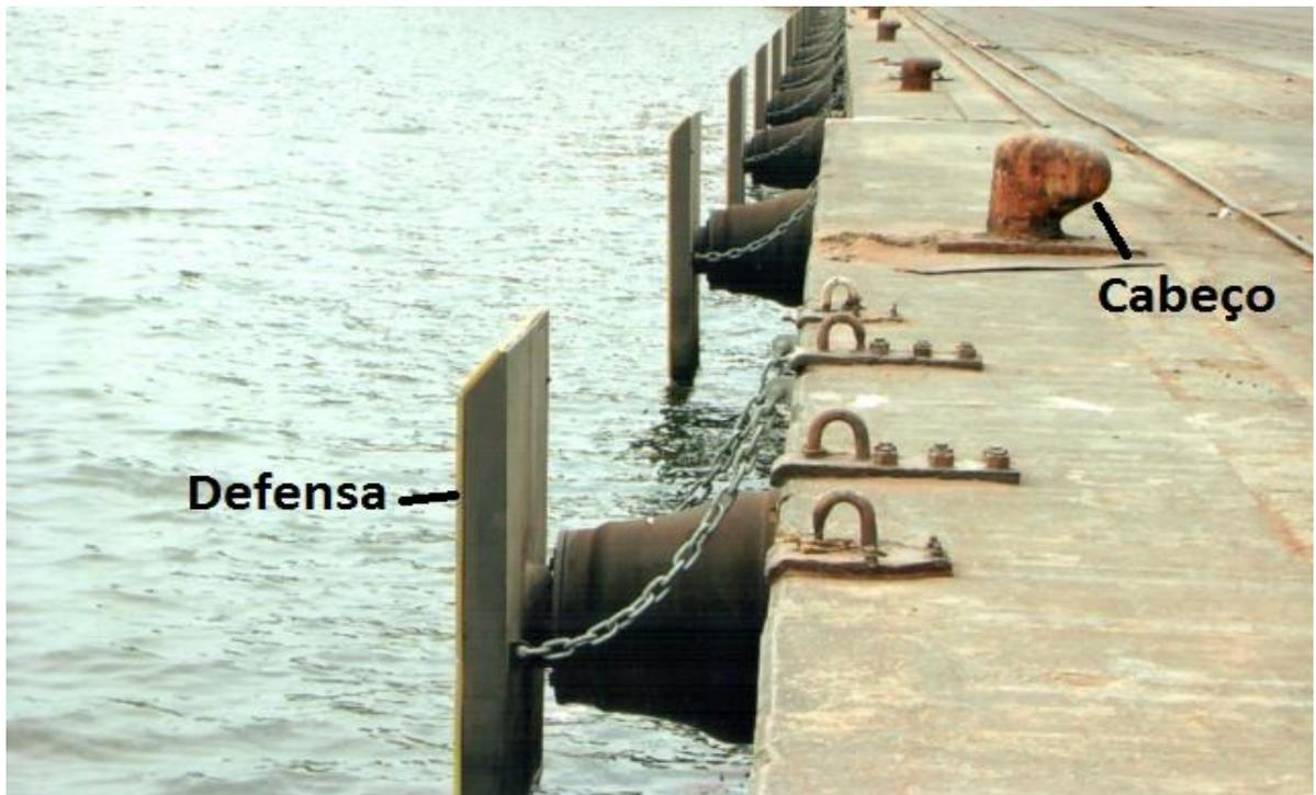
Figura 6 - Cabeço de ferro fundido e Defesa do tipo Bridgestone.
