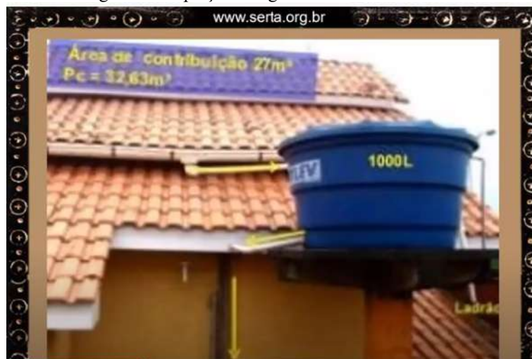
Figura 7 - Captação da água da chuva de uma casa
