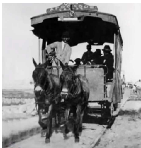
FIGURA 1 – Superestrutura viária no século XIX
