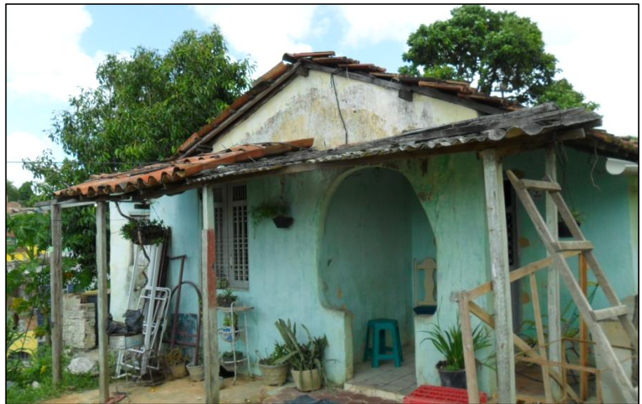
Foto 5.1 – Moradias em alvenaria (meia encosta) (a) e (b)
