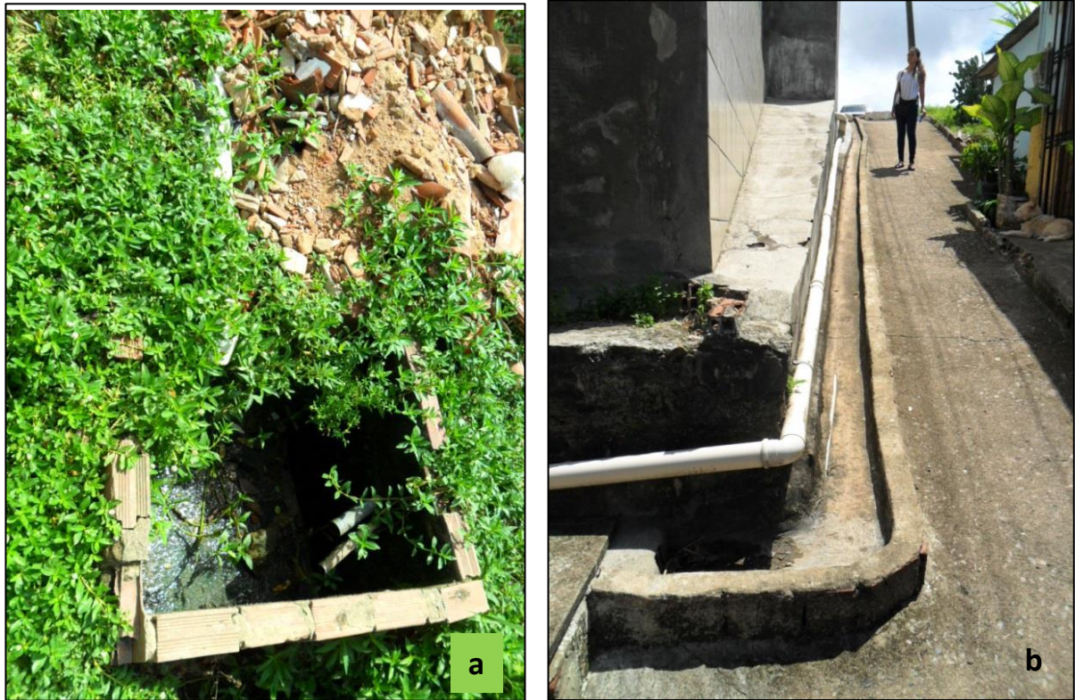
Foto 5.5 – Drenagem existente de águas servidas (a) e águas pluviais (b)
