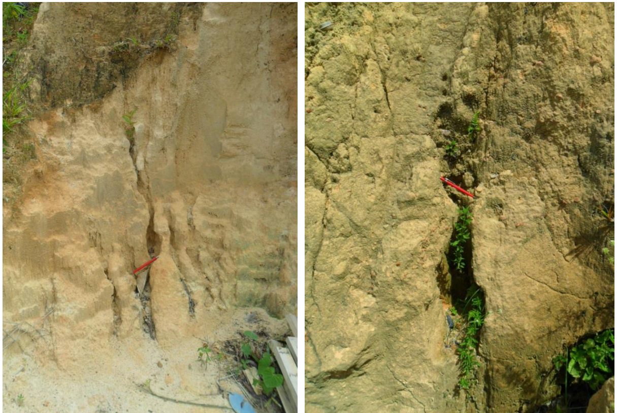
Foto 5.9 – Presença de fissuras nos taludes
