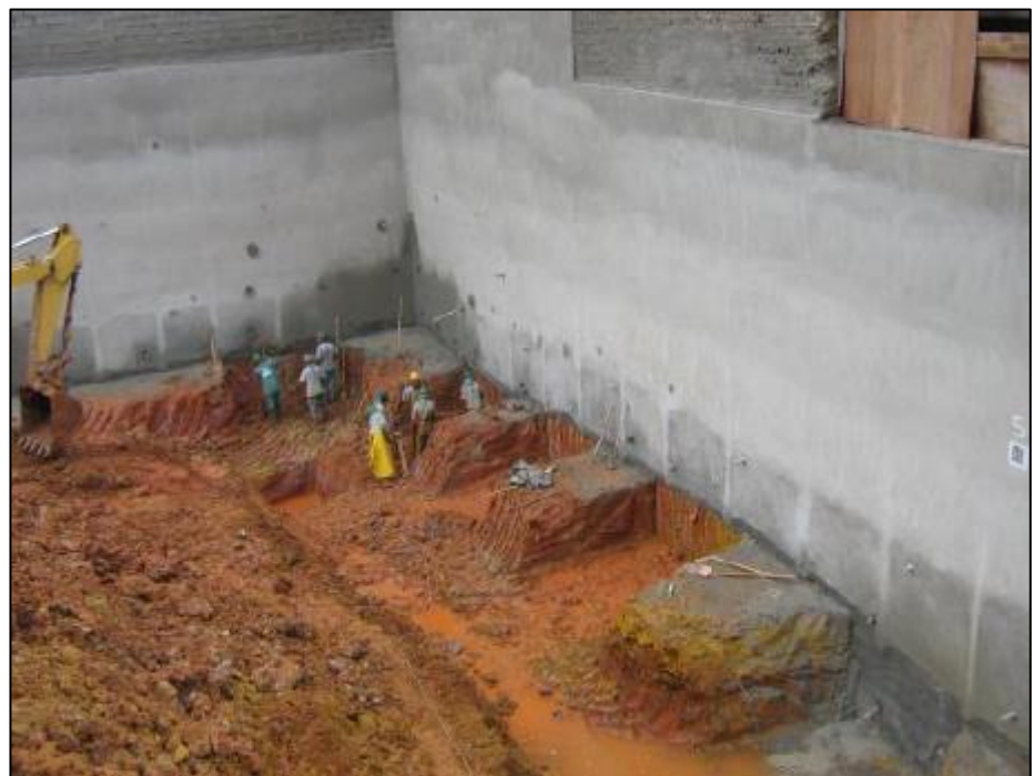
Figura 2.16 - Escavação com berma de equilíbrio
