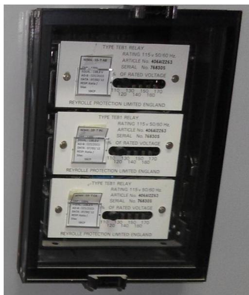
**Figura 2.5 - Relé de Sobretensão (59), Reyrolle
