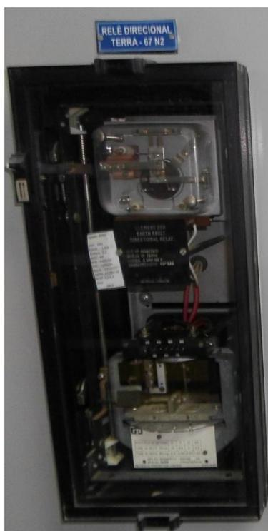
**Figura 2.3 - Relé direcional de sobrecorrente de Neutro (67N), Reyrolle**
