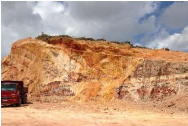
A área onde está situado o talude estudado, na época da coleta de amostras, encontrava-se caracterizada pelo corte de barreira para criar terreno; aumento do talude de corte para ampliação do terreno; inexistência de calhas, biqueiras, impermeabilização no talude e canaletas para a drenagem das águas pluviais.
