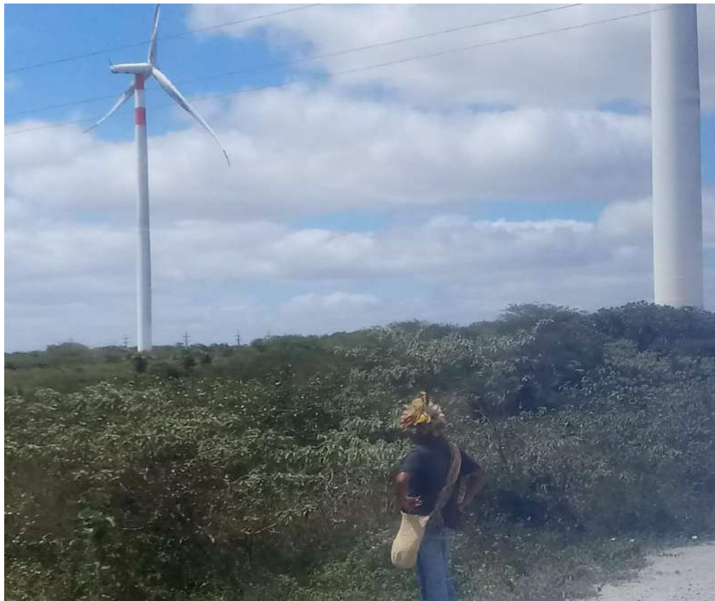
Figura 9 - Parque eólico – Tacaratu-PE
