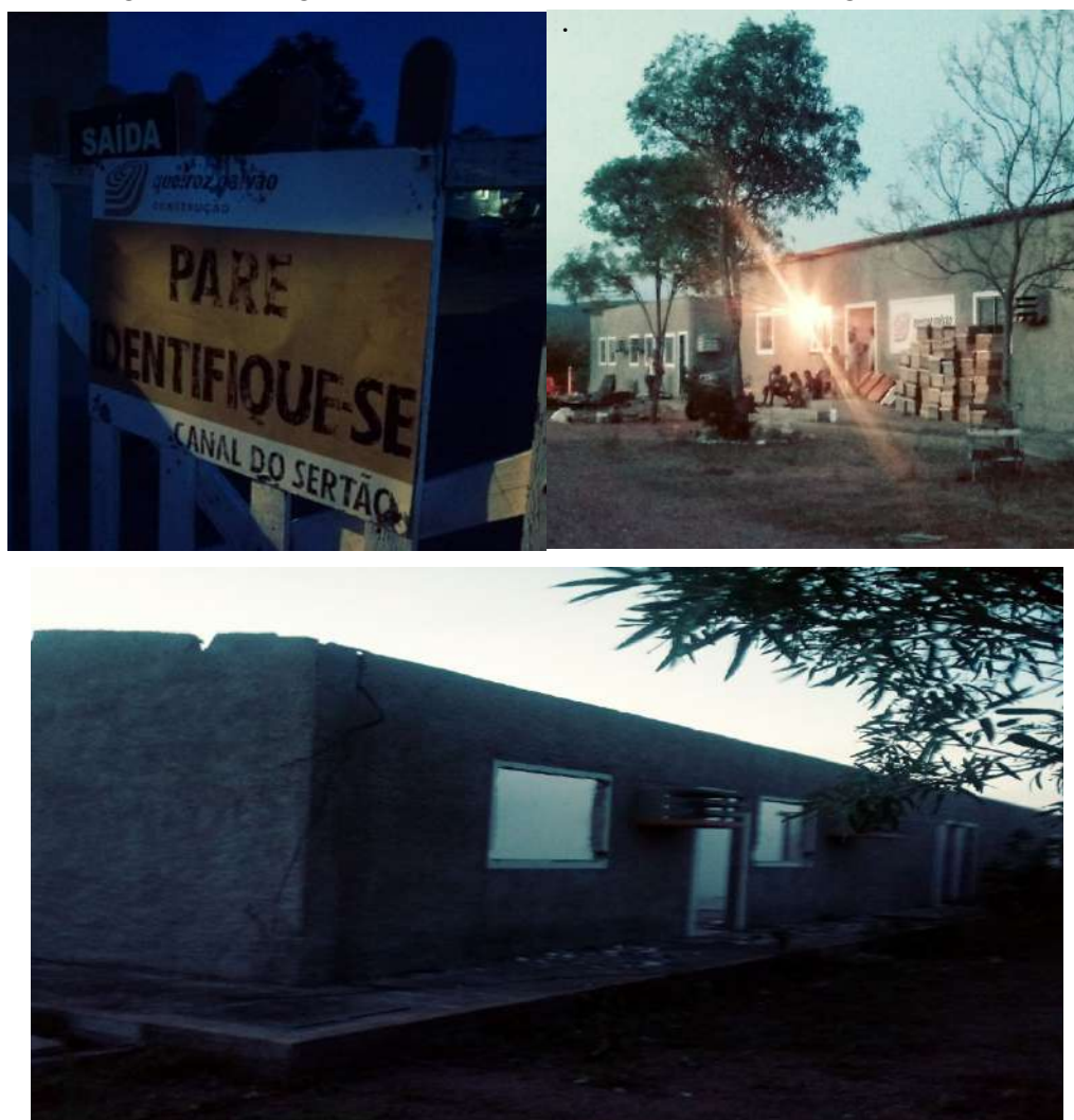
Figura 50 - Antigo escritório da Obra Canal do Sertão em Água Branca-AL
