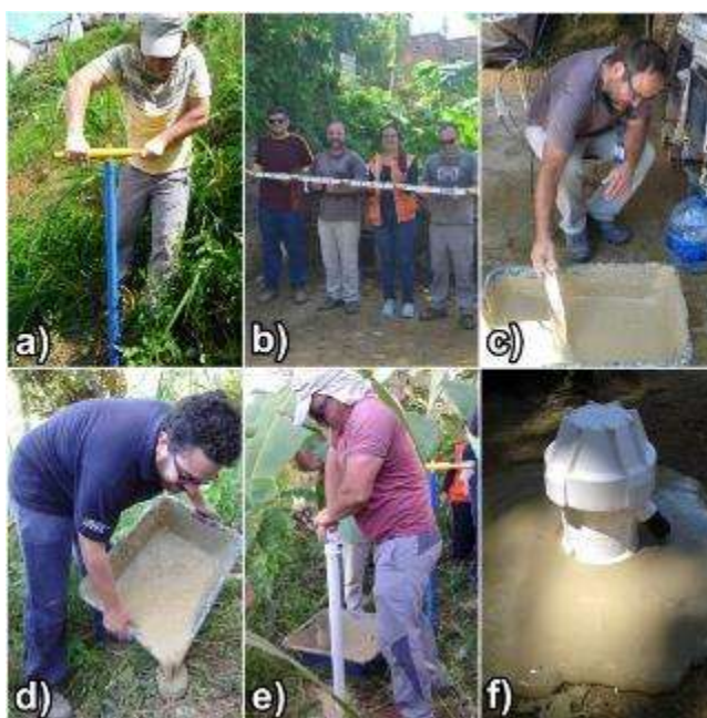
Figura 62 - Procedimentos para instalação da sonda do tipo EnviroScan: a) abertura do furo; b) acondicionamento dos sensores no tubo de PVC; c) preparação do slurry com caulinita; d) inserção do slurry no furo; e) inserção da sonda no furo; f) finalização.
