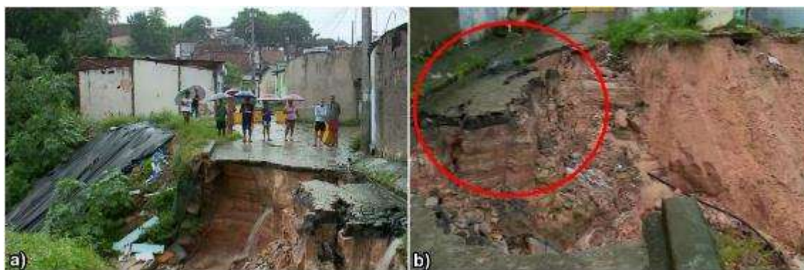
Figura 31 - Deslizamento na rua São Xavier: a) Imagem do deslizamento; b) Detalhe da ruptura e indicação da formação de blocos.
