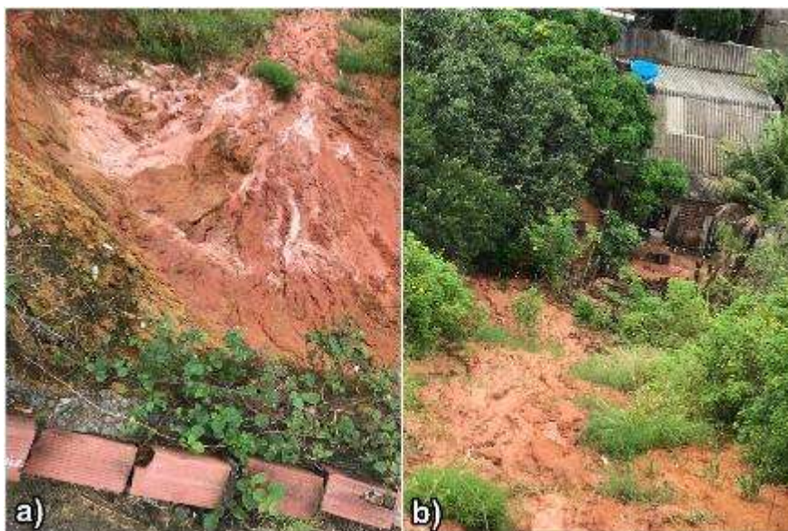
Figura 47 - Deslizamento ocorrido em junho de 2019: a) Ruptura; b) Material deslizado.
