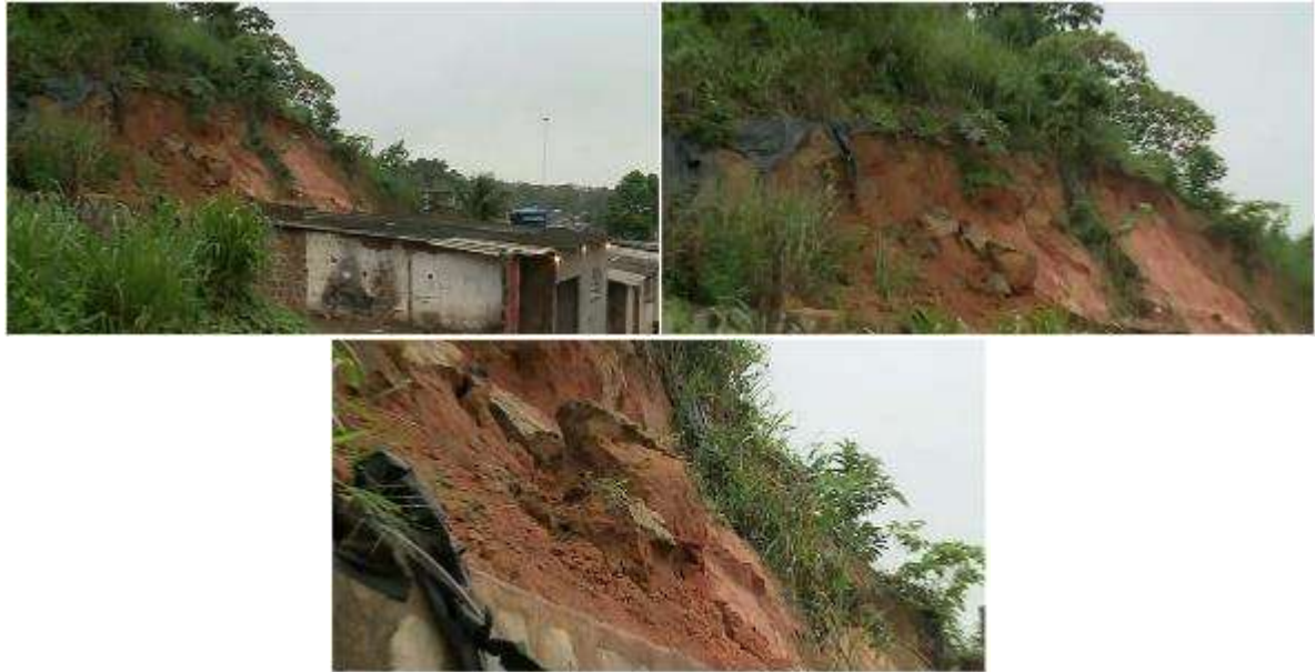
Figura 34 - Deslizamento na rua Alto Santa Izabel em junho de 2020.
