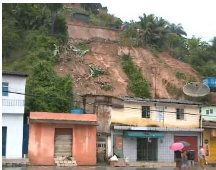
Figura 35 - Deslizamento na avenida Chapada do Araripe em maio de 2021.
