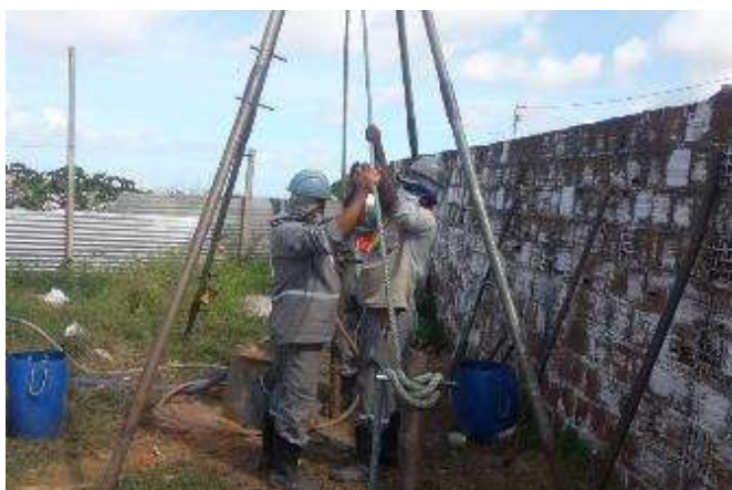
Figura 50 - Execução do Ensaio SPT no ponto P-11.
