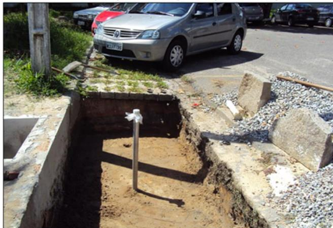
O equipamento no centro da vala escavada consiste em um tubo de alumínio que foi previsto inicialmente para o monitoramento diário da umidade volumétrica no perfil de solo com a sonda de nêutrons. Esse equipamento foi danificado, impossibilitando a coleta dos dados de umidade.
