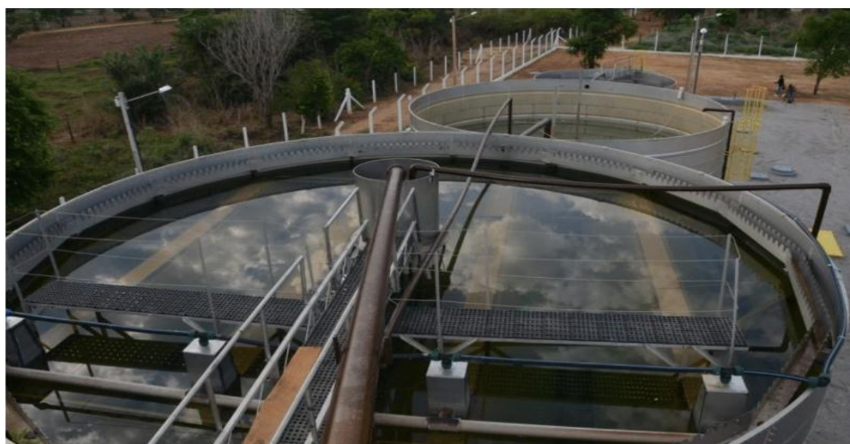
Figura 9 – Exemplo de reator UASB.
