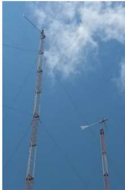
Figura 15 - Torre meteorológica e do aerogerador empregadas nas medições das características do vento na região do projeto PILACAS.
