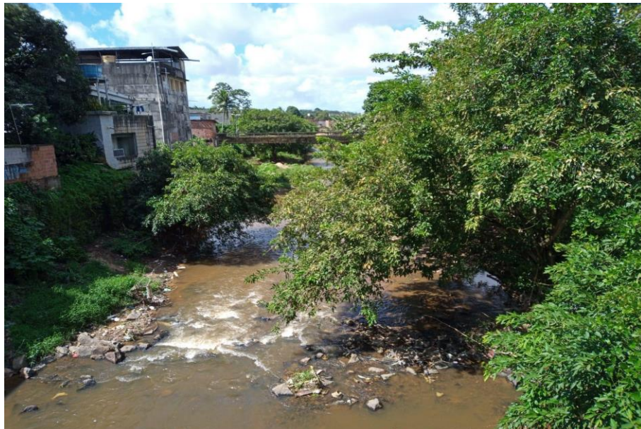
Figura 7 – Margem esquerda da ponte que dá acesso ao Bairro de Vila Rica: sentido Centro - Vila Rica
