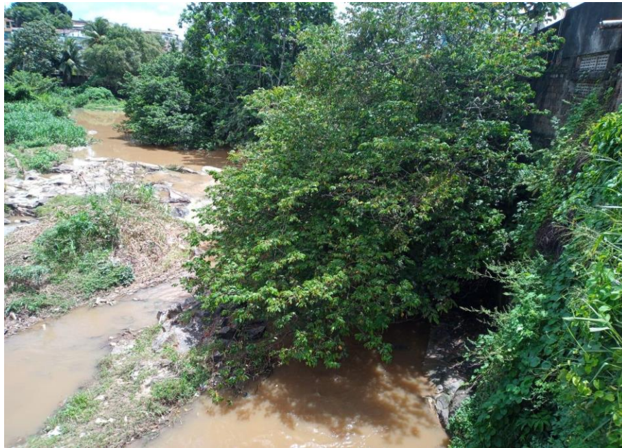
Figura 6 – Margem direita da ponte que dá acesso ao Bairro de Vila Rica: sentido Centro - Vila Rica
