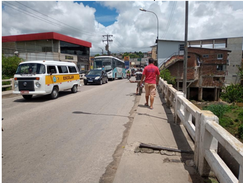
Figura 2 – Ponte sobre o Rio Jaboatão: principal acesso ao bairro de Vila Rica, Jaboatão dos Guararapes-PE
