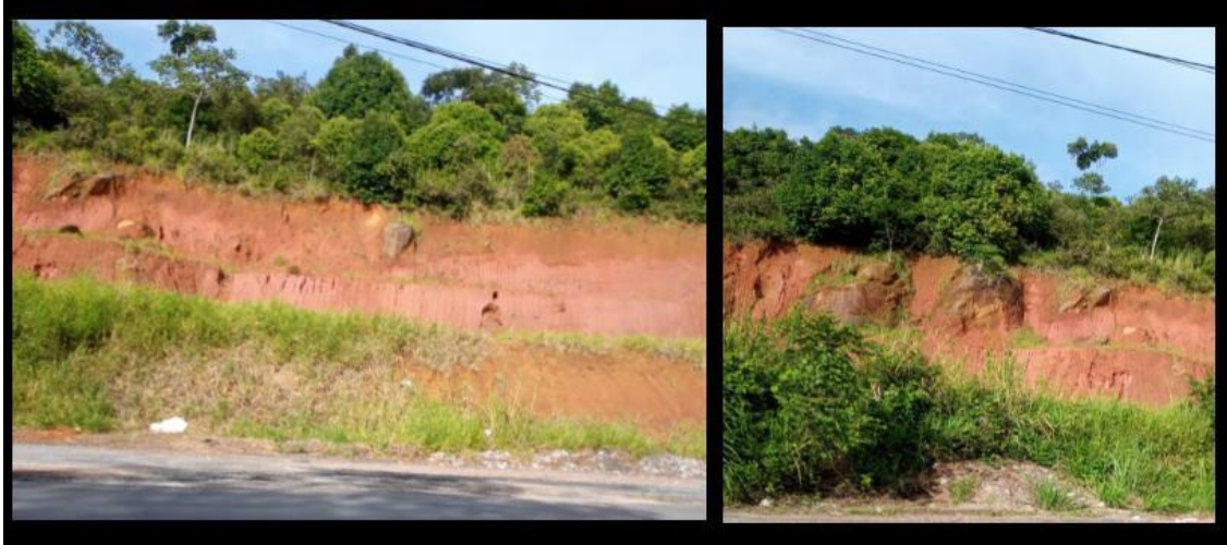
Figura 20 – Erosão causada pela extração da argila. Muribeca, Jaboatão dos Guararapes/PE
