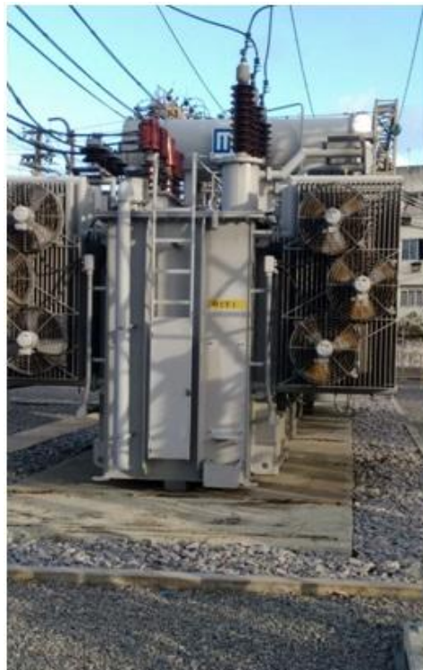
Figura 5 – Transformador de potência trifásico.
