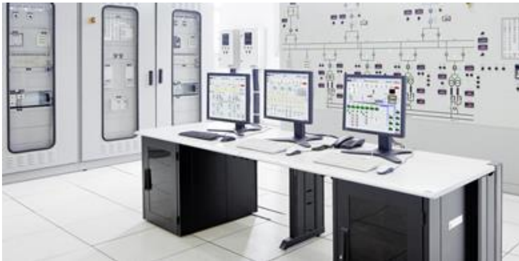
Figura 13 – Sistema de automação da subestação.
