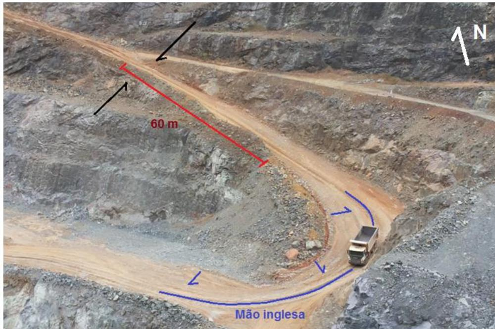
**Figura 16: Via com presença de estrangulamento e mão inglesa**
