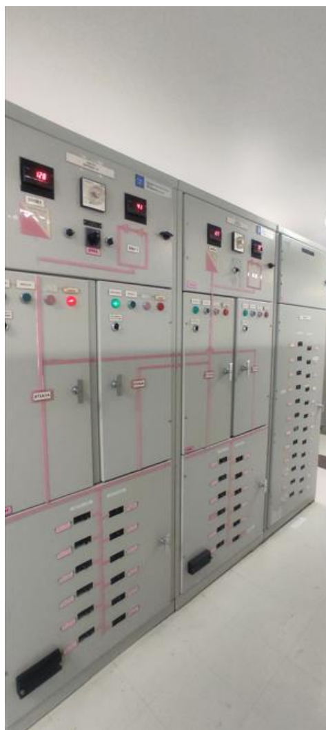
Figura 25 - Painéis de Serviços Auxiliares 125Vcc
