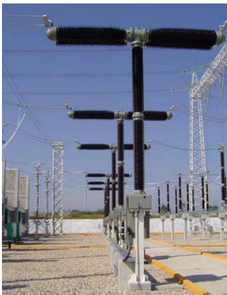
Figura 9 - Disjuntores de Alta Tensão
