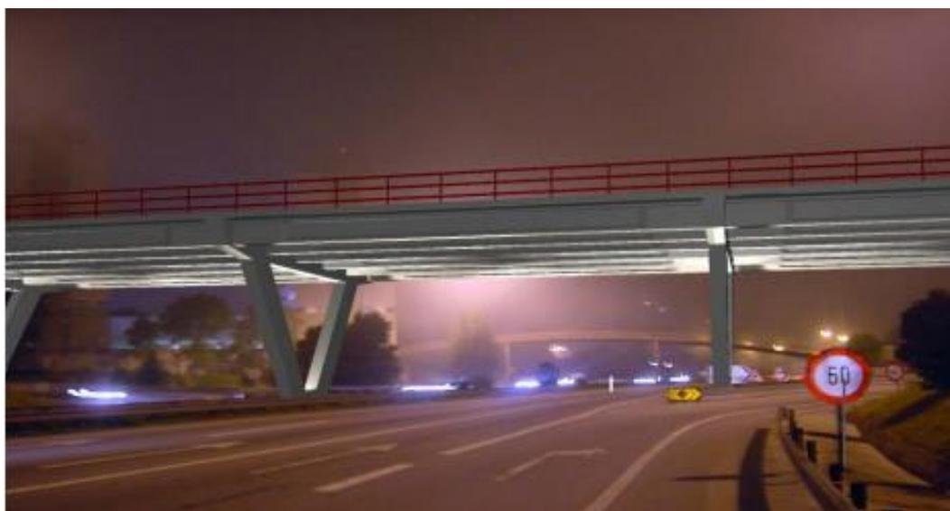
Figura 4.4 – Ponte em viga pré-moldada com continuidade na viga.
