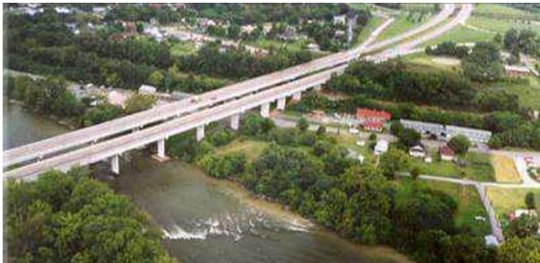
Figura 3.3 – Kingsport Bridge, Tennessee, EUA. Ponte mais extensa construída com vigas pré-moldadas protendidas.
