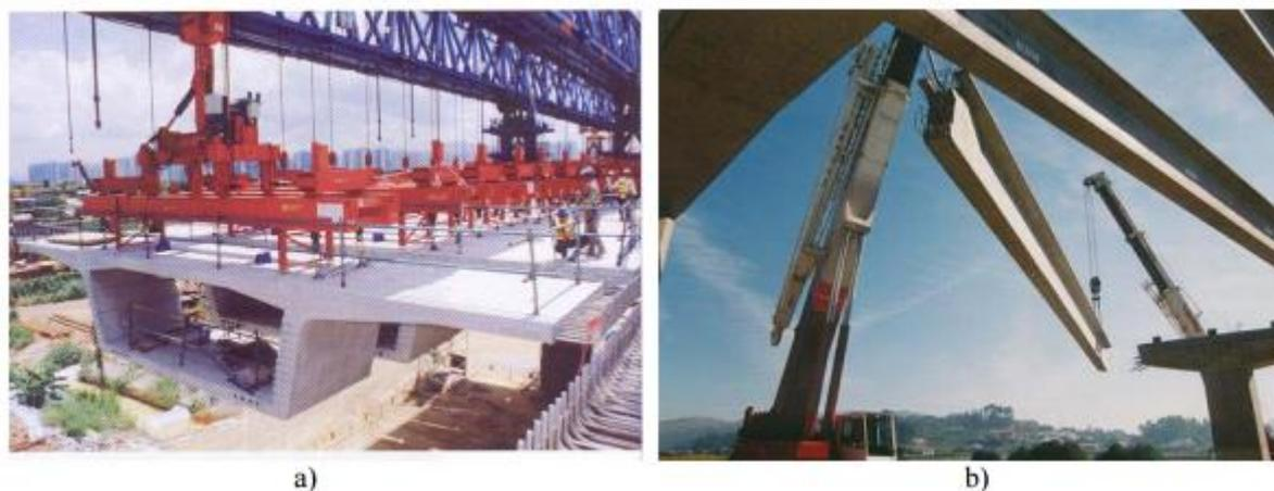
Figura 4.1 - Elementos pré-fabricados utilizados em tabuleiros de pontes: a) aduelas pré-fabricadas; b) vigas pré-fabricadas.
