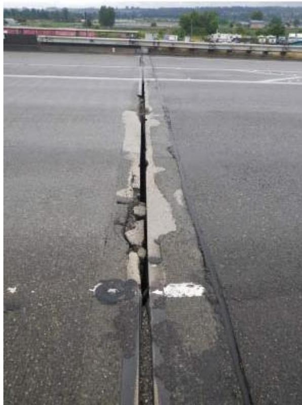
Figura 2.2 – Estado de deterioração das juntas da ponte Ebey Slough Bridge, Washington, EUA. (foto WSDOT)
