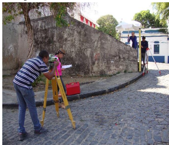
Figura 25 – Nivelamento Geométrico e RNSP
